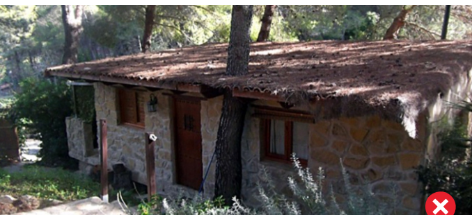
Casa amb biomassa a la teulada.
