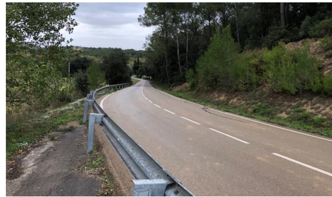
Fotografia 36: Alternativa 2 – Tram d'aprofitament de la carretera actual. PK 1+840 (sentit nord)
