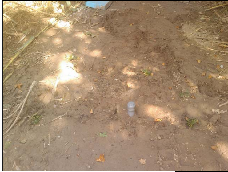
Foto 25: Tub piezomètric instal·lat a S3.
