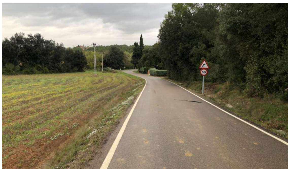
Fotografia 34: Alternativa 2 – Tram d'aprofitament de la carretera actual. PK 1+740 (sentit nord).
