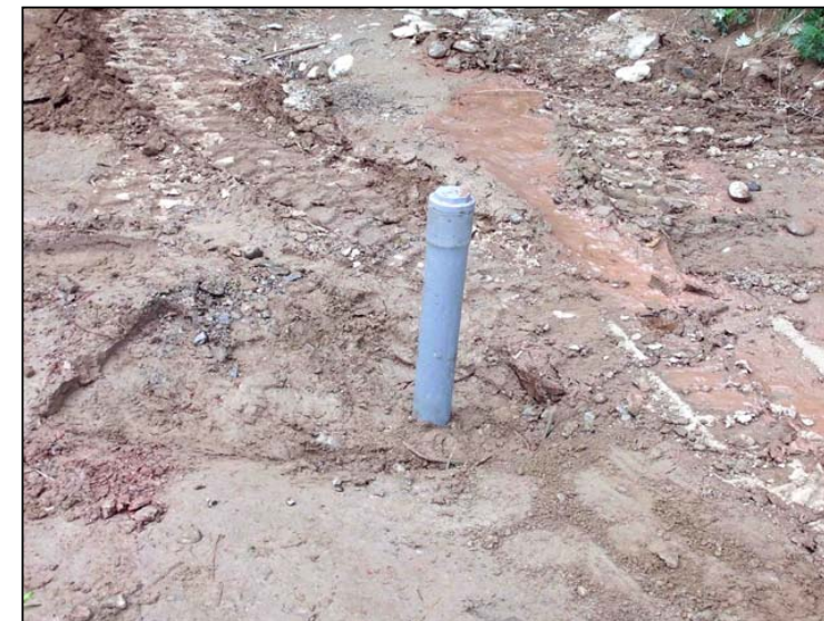
Foto 27: Tub piezomètric instal·lat a S4.
