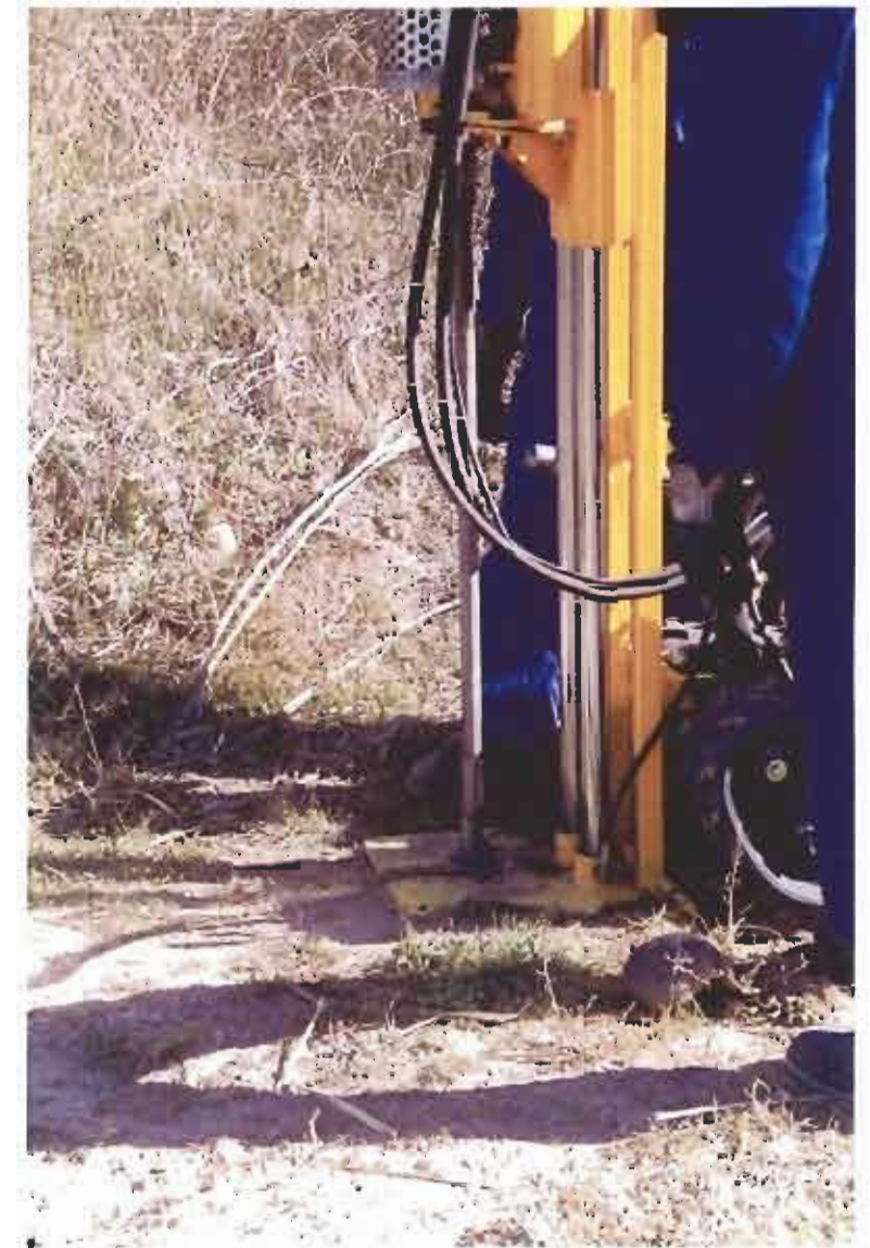
Detall de la perforació del penetròmetre P-1
