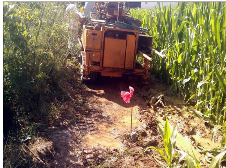
Foto 22: Tub piezomètric instal·lat a S1.
