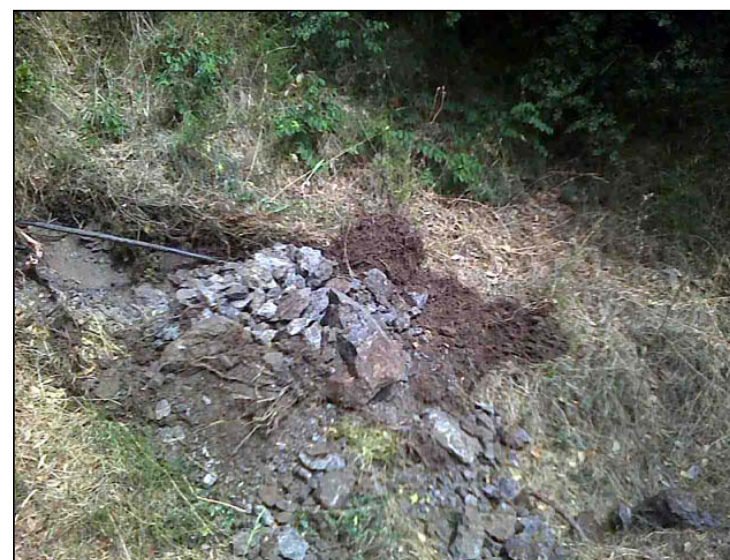
Foto 4: Material extret Cata CT-2.
