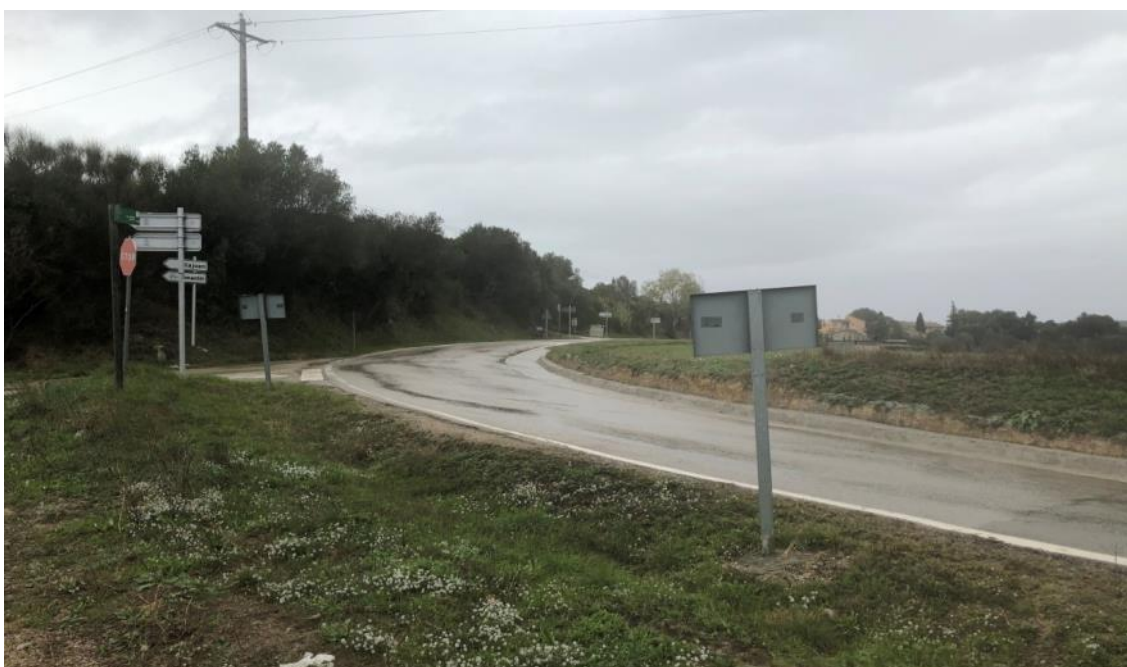
Fotografia 10: Alternativa 1 – Vista de la zona a ocupar. PK 0+820 (sentit nord).
