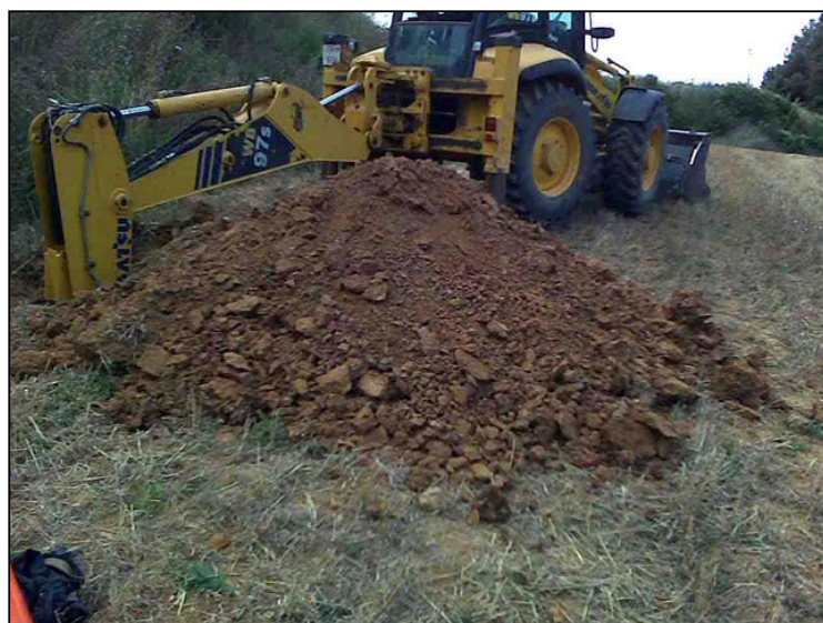
Foto 2: Material extret Cata CT-1.
