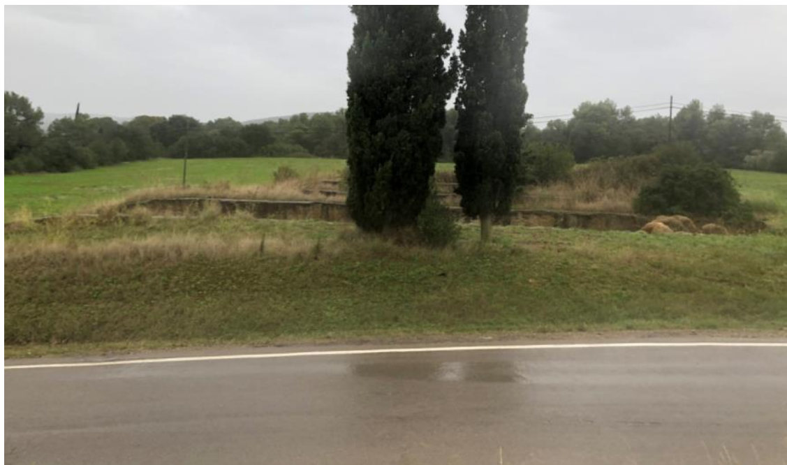
Fotografia 9: Alternativa 1 – Vista de la zona a ocupar. PK 0+800 (sentit sud) (II).
