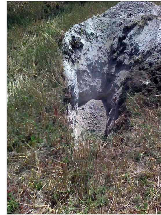
Foto 11: Excavació Cata CT-6.
