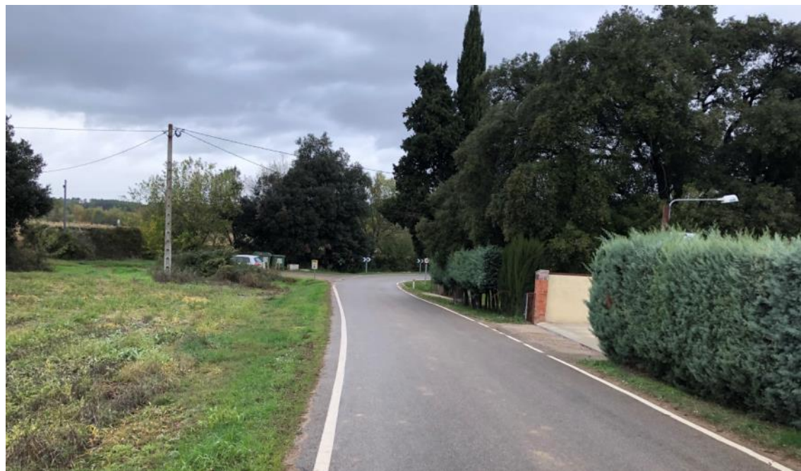
Fotografia 33: Alternativa 2 – Tram d'aprofitament de la carretera actual. PK 1+680 (sentit nord).
