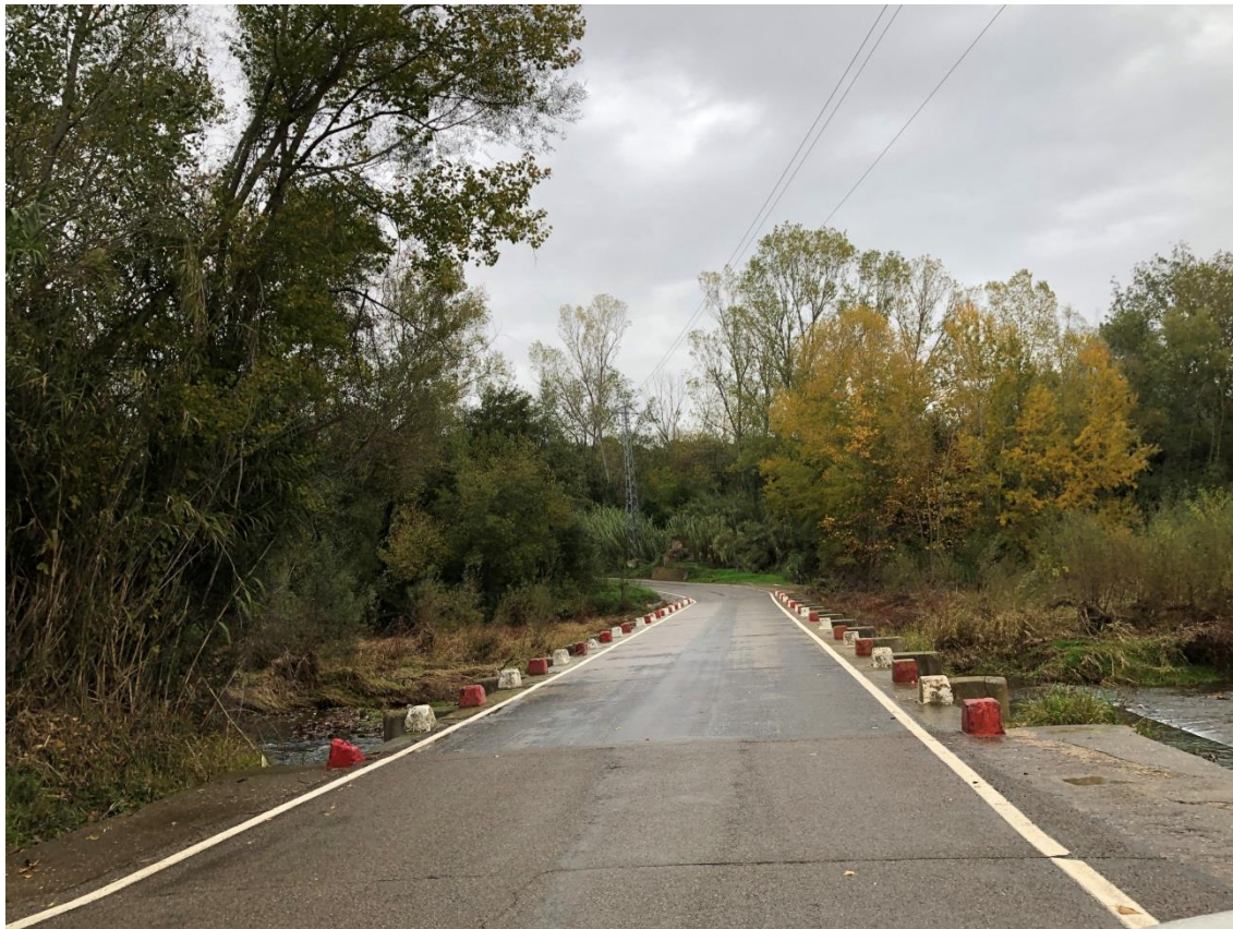
Fotografia 1.1. Gual existent a l'actual carretera GI-V-6226
