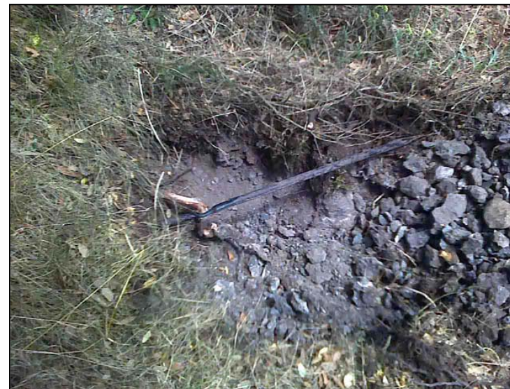
Foto 3: Excavació Cata CT-2.
