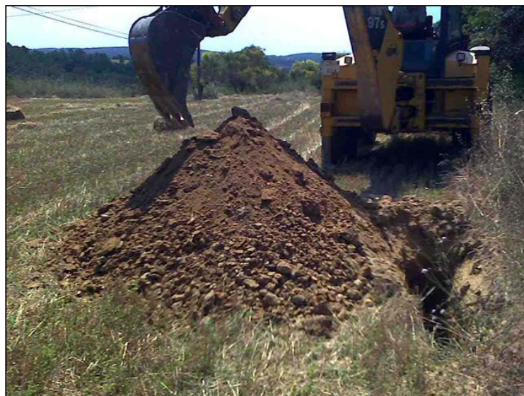
Foto 10: Material extret Cata CT-5.
