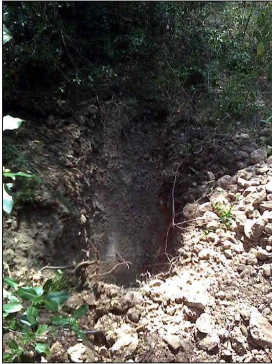
Foto 5: Excavació Cata CT-3.
