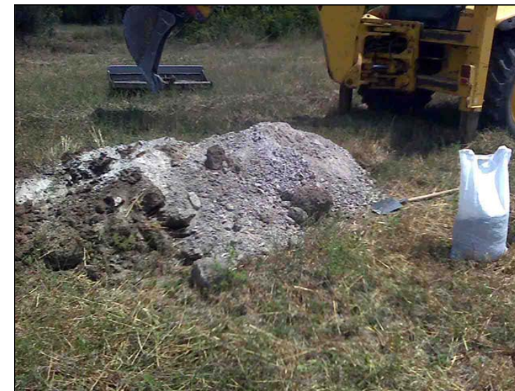
Foto 12: Material extret Cata CT-6.
