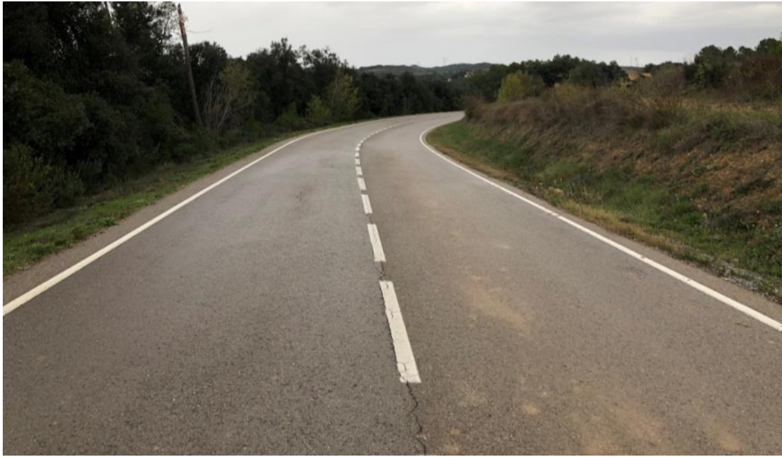
Fotografia 45: Entroncament amb carretera actual al tram final (sentit nord) Alternativa 1 – PK 1+996 Alternativa 2 – PK 2+125
