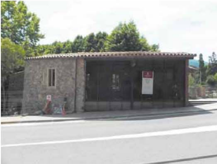
>> Nau superior de la farga, on es pot observar com fou retallada parcialment en el moment d'ampliar la carretera. En la restauració s'ha respectat aquesta actuació i s'ha aprofitat per convertir-la en un gran aparador que permet veure l'interior de l'edifici.
