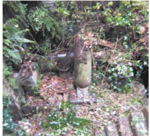
>> Primer pla de la turbina instal·lada als anys trenta en el moment d'endegar la intervenció. Aquest sector de l'edifici ja havia perdut la seva coberta, de forma que l'interior estava totalment ocupat per runes i heures.
