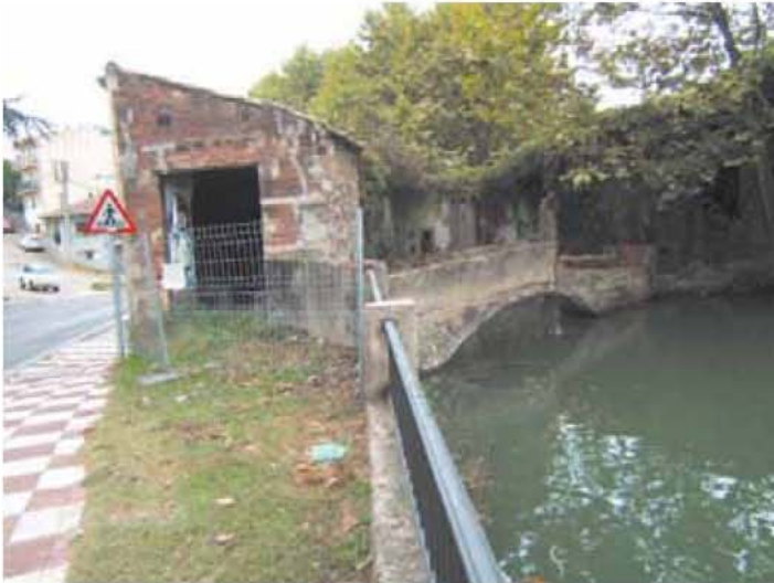
>> Vista parcial de la part superior de l'antiga farga. S'hi pot observar parcialment la bassa, el pont que la travessa i la nau que fou retallada quan s'amplià la carretera annexa. Tot el conjunt presenta un estat total d'abandó i ruïna.
