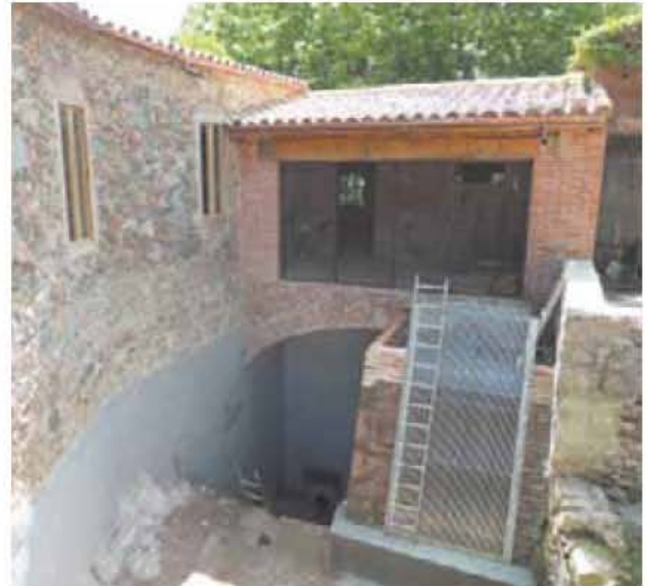
>> Embocadura de la bassa en el moment de ser restaurada. S'hi pot observar com s'optà per mantenir la darrera fase de funcionament, ja que es manté la divisió en dos sectors.
