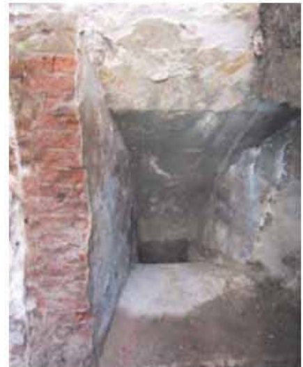
>> Embocadura per on sortia l'aigua de la bassa cap a la roda que tenia una forma especial, que li permetia donar una major pressió a l'aigua.
