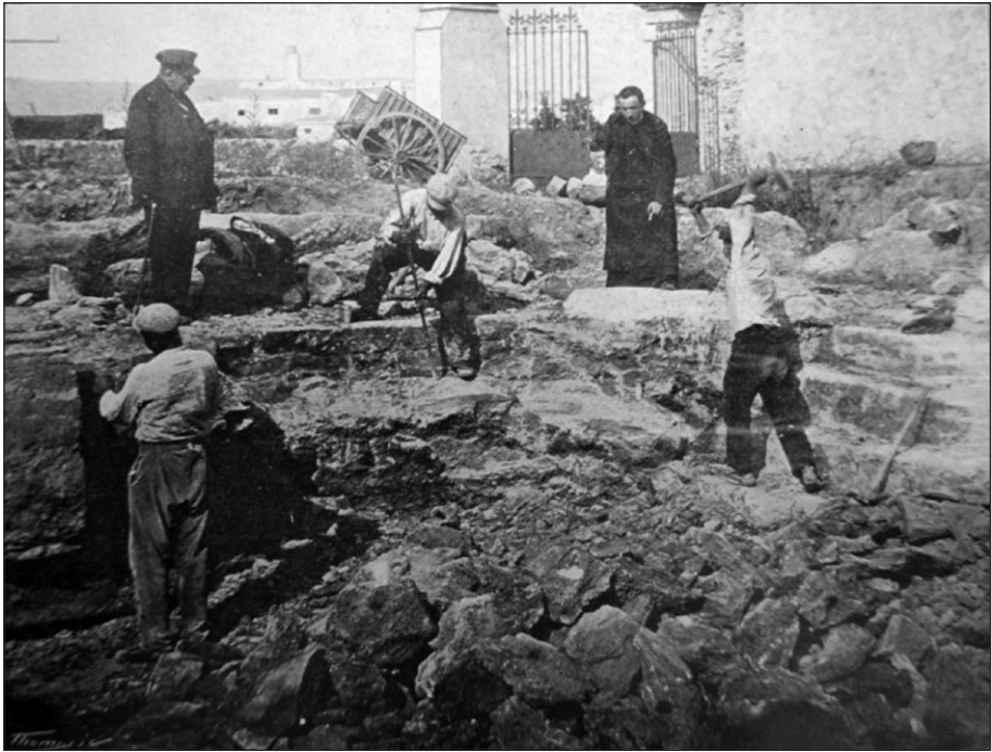
Vista parcial de les tasques d'excavació de les termes feta per Norbert Font. La important capa de sediment calcari que s'havia dipositat sobre les restes obligà a excavar el conjunt termal a barrinades i cops de mall.
