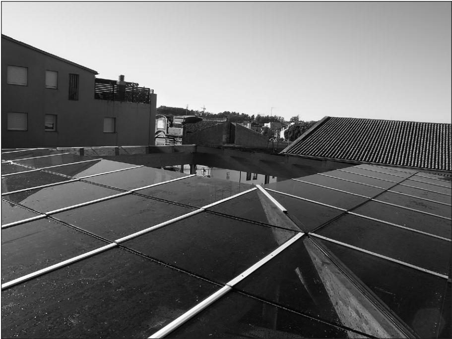
Vista general de la coberta de les termes un cop instal·lada. Aquesta està formada per una estructura de fusta recoberta de peces vidre laminar, que protegeix el conjunt però l'emmaskaren.
