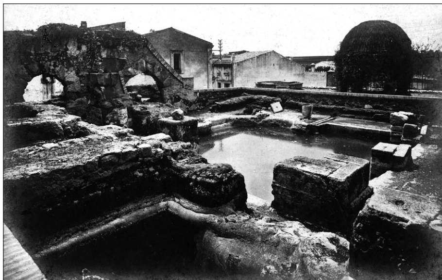
Vista general de les termes romanes després de la intervenció feta als anys vint. Hi podem observar com es va bastir una font coberta per una glorieta vegetal, des de la qual sortia l'aigua que omplia de nou la piscina romana.
