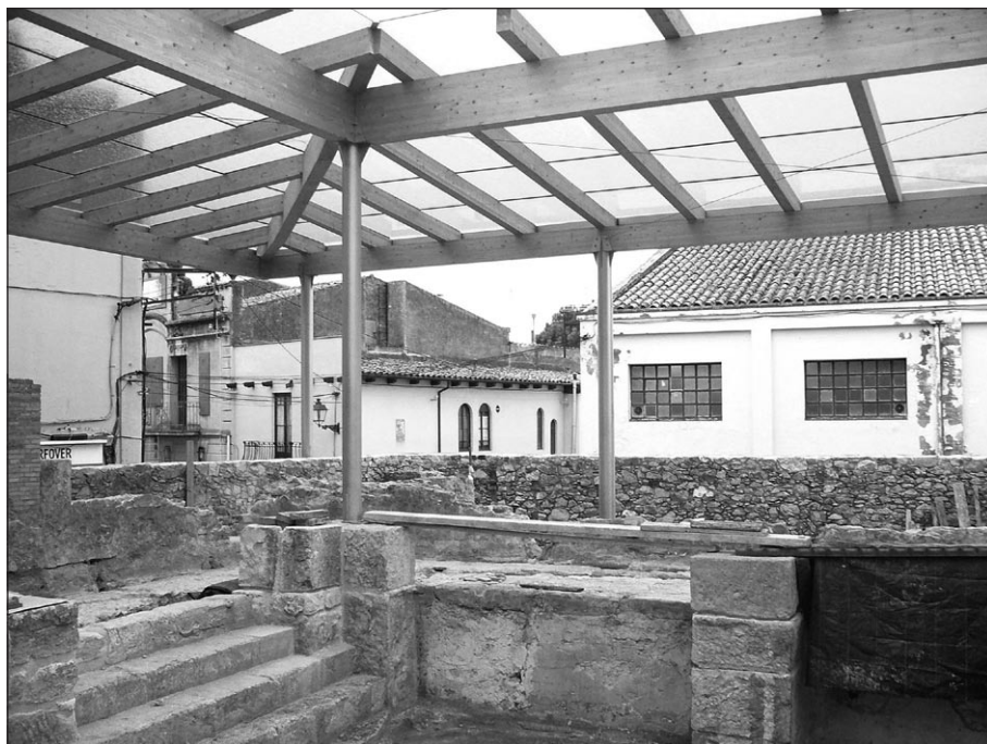
Vista parcial de la coberta de les termes romanes, amb la qual es pretén protegir el monument de la pluja i les humitats que estaven malmetent les restes i amenaçaven amb produir-ne la desaparició total.
