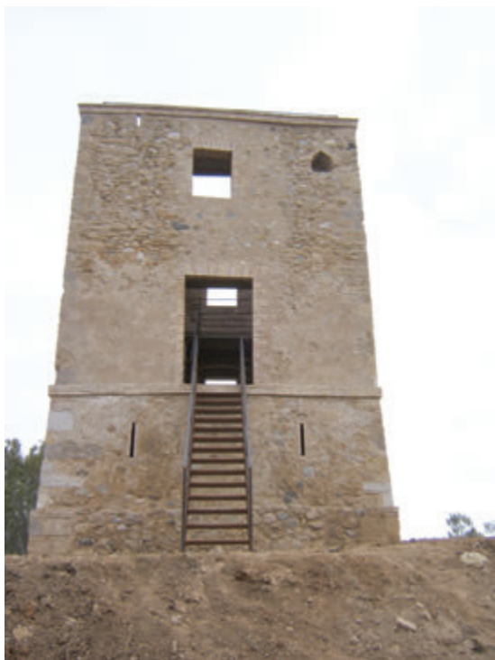
Figura 10: Vista general de la fachada principal de la Torre de l'Àngel una vez restaurada. Para acceder al conjunto se ha optado por construir una escalera metálica, que imita la original de madera.
