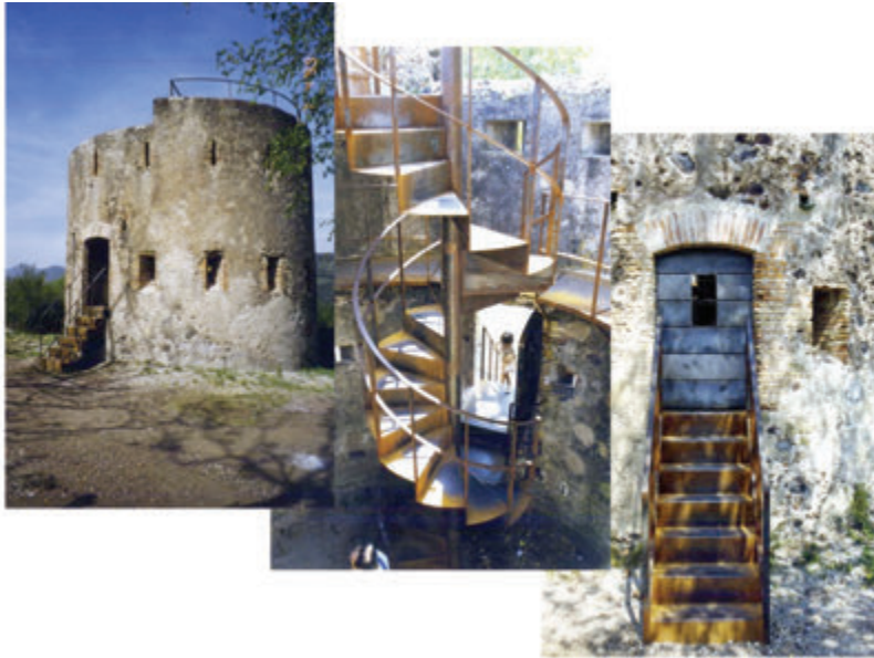
Figura 3: Interior de una de las torres de Sant Francesc una vez restaurada. En ella podemos observar como el acceso a los diferentes niveles de la torre se efectúa mediante una escalera de caracol metálica y recuperando un nivel de circulación perimetral (pasarela), que permite acceder a los diferentes espacios de la torre.
