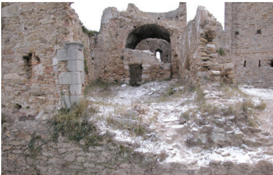
Figura 4: Vista general de la torre de las torres de telegrafía óptica de Sant Miquel antes de su restauración. En ella podemos observar el estado de ruina total que presentaba la ermita reconvertida en torre militar (izquierda de la imagen), la civil (solo visible parcialmente a la derecha) y el foso que las rodeaba, lleno de escombros y plantas.
