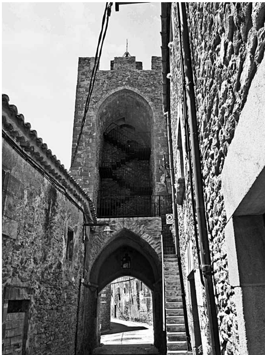
Figura 3: vista de la part posterior de la torre de les Hores un cop restaurada pel Servei de Monuments. S'hi pot observar la rehabilitació de l'escala de pedra que permet l'accés al primer pis, ja destapiat, i l'escala metàl·lica que permet pujar a la part superior de la torre.
