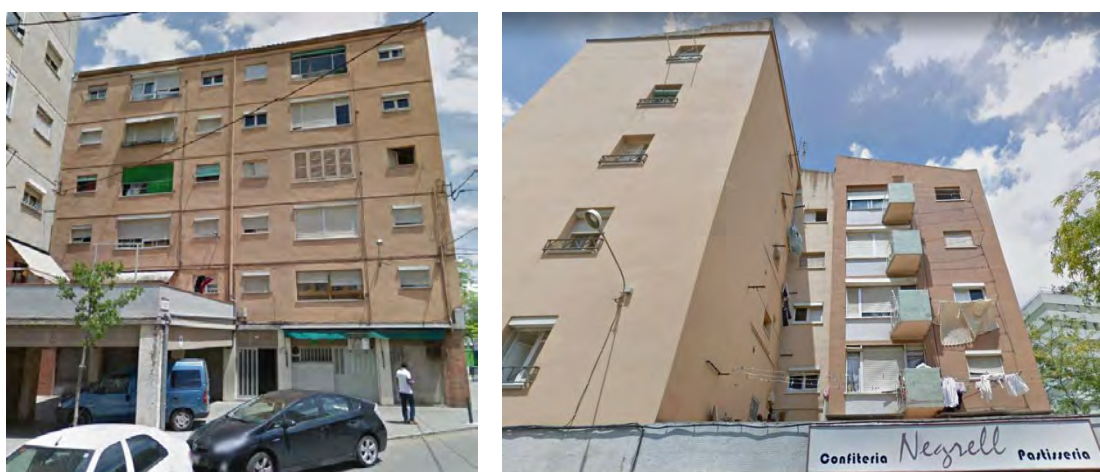
Figura 4.20. Imatges de la façana sud-oest (esquerra) i sud-est (dreta) del bloc plurifamiliar de Salt.
