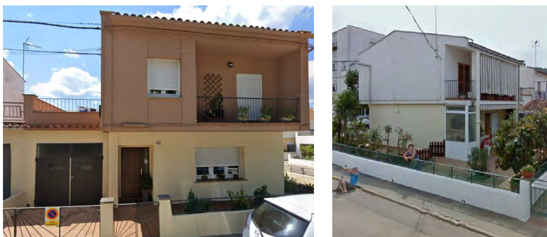
Figura 4.3. Imatges de les façanes sud-est (esquerra) i nord-est i nord-oest (dreta) de la casa unifamiliar de Bescanó.
