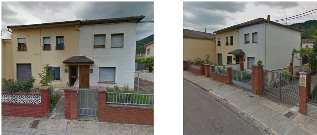
Figura 5.16. Imatge de la façana est (esquerra). A la dreta s'observa una visió en escorç on apareix tant la façana est com la façana nord (cega) de la casa unifamiliar del carrer Sant Cristòfol.
