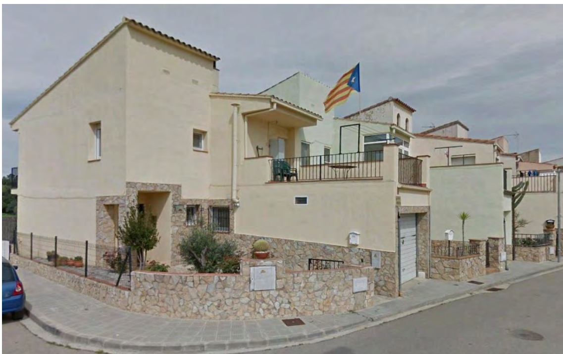
Figura 3.5. Imatges de les cases en filera de la barriada de Santa Cristina.
