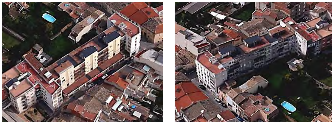
Figura 4.7. A l'esquerra, la façana sud-oest. A la dreta, la façana nord-est.
