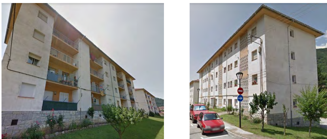
Figura 5.13. Imatges de la façana nord-oest (esquerra) i sud-est (dreta) del bloc plurifamiliar de Ribes de Freser 1 .
