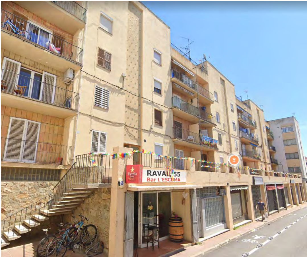
Figura 4.6. Imatges de la façana sud-oest del bloc plurifamiliar de Cassà.
