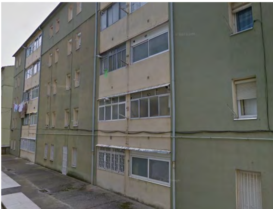
Figura 5.3. Imatges de la façana sud-oest (a sobre) i nord-est (a sota) del bloc plurifamiliar del carrer Fargaies.
