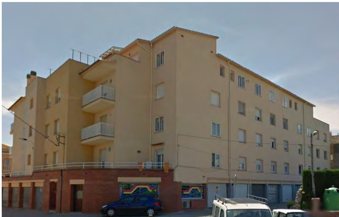
Figura 3.19. Imatges del bloc plurifamiliar de Verges. A dalt s'observa la façana sud. A baix tenim els alçats est (esquerra) i nord (dreta), respectivament.
