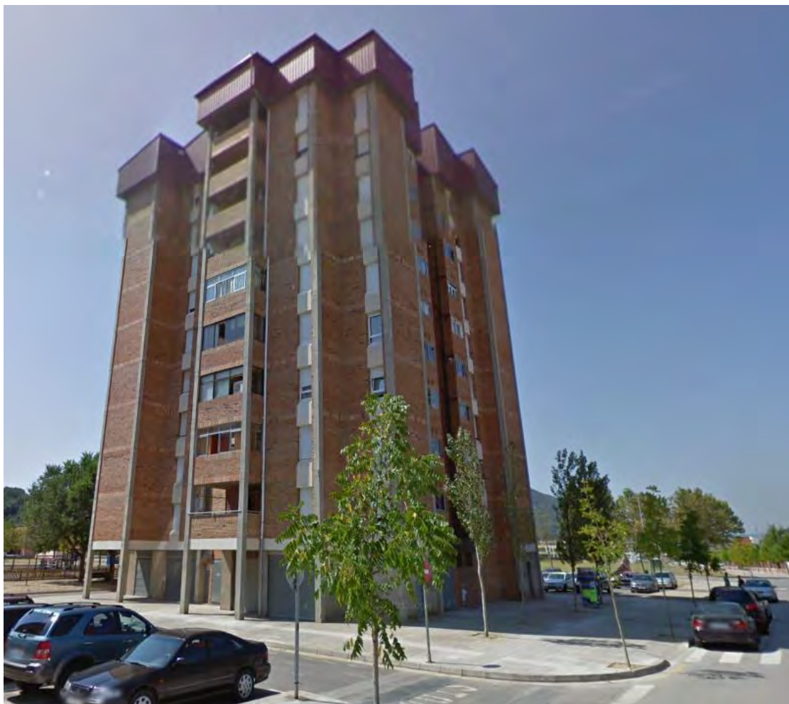
Figura 4.13. Imatge de la façanes nord i est del bloc plurifamiliar.
