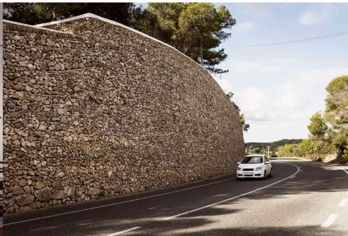
12 - Paret de pedra seca en una de les carreteres principals de Menorca, que en aquest cas serveix per contenir el terreny i evitar que hi hagi esllavissades a la via.
