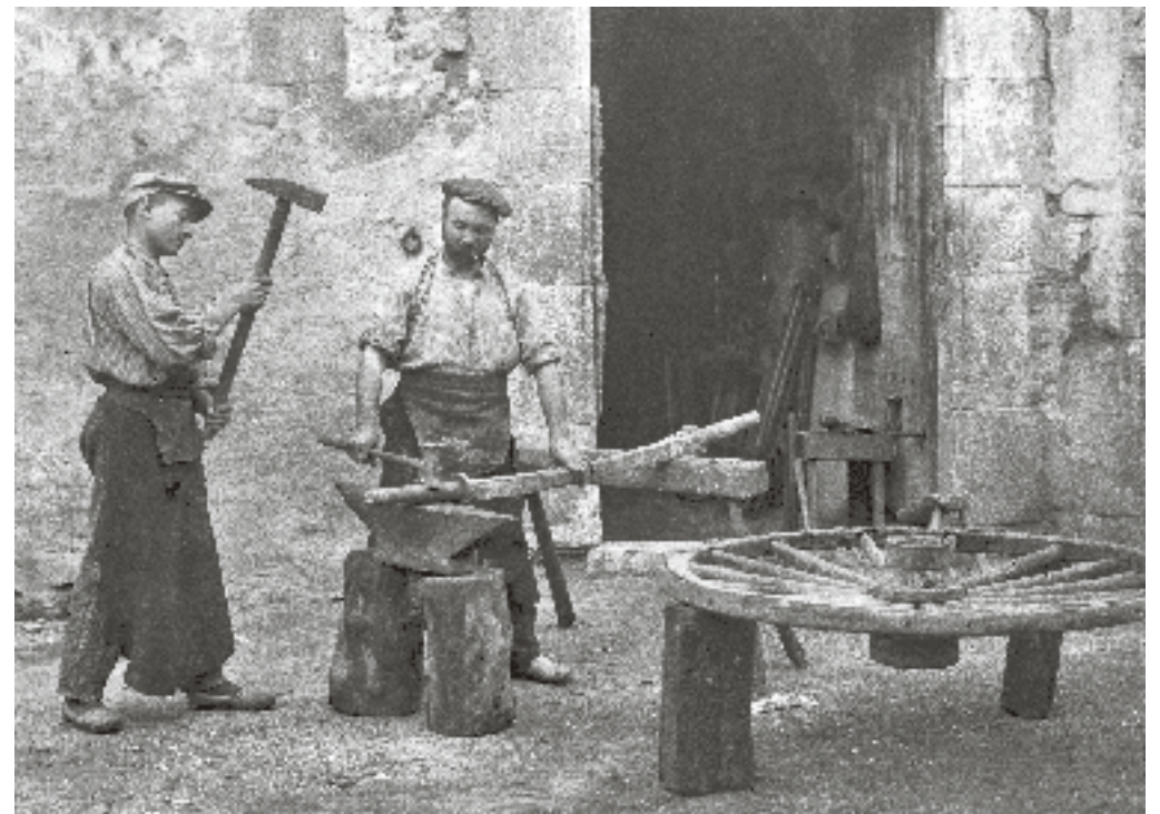
Ferrers treballant en l'eix d'un carro davant del seu taller, [s. l.], 1911-1944. Fons Valentí Fargnoli.
