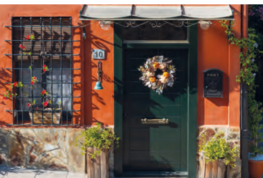
>> Façana d'una casa del barri vell de Santa Cristina d'Aro.
