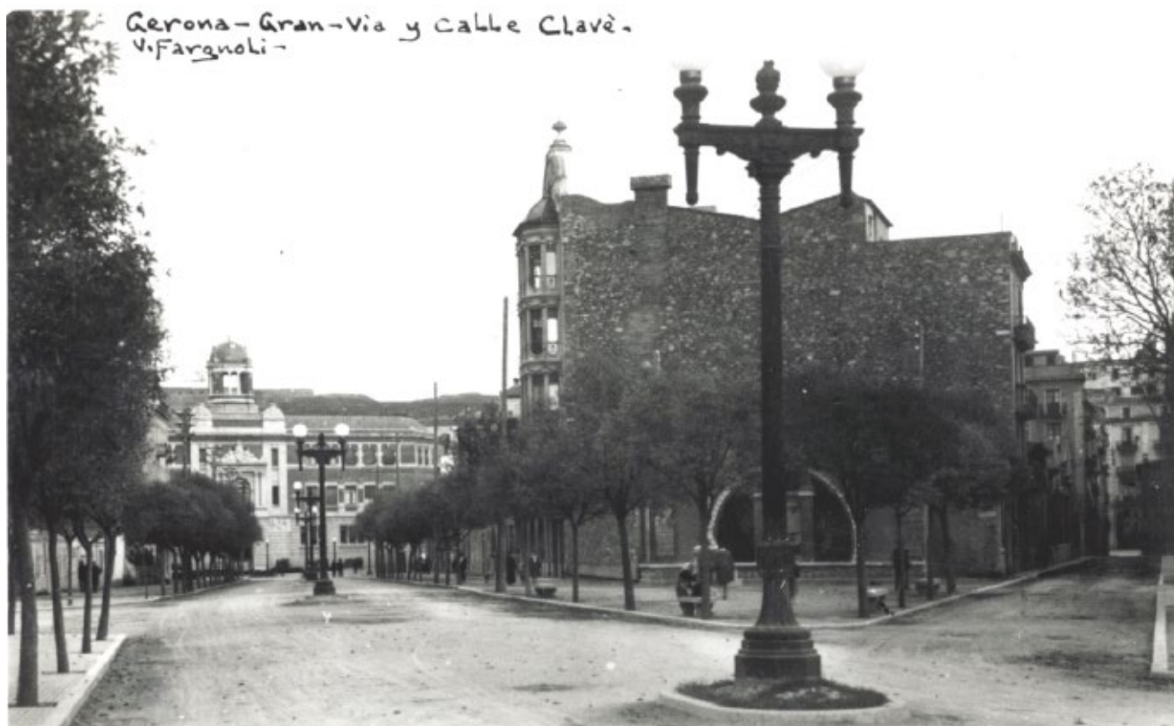
>> Gran Via de Jaume I als anys vint o inicis dels trenta. L'edifici rere el fanal era un dels transformadors que subministraven corrent al barri. (Font: AJUNTAMENT DE GIRONA. CRDI. VALENTÍ FARGNOLI.)
