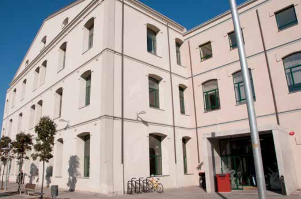
>> L'exterior de l'edifici, situat a la plaça de l'U d'Octubre. (Autoria: JORDI CARALT)
