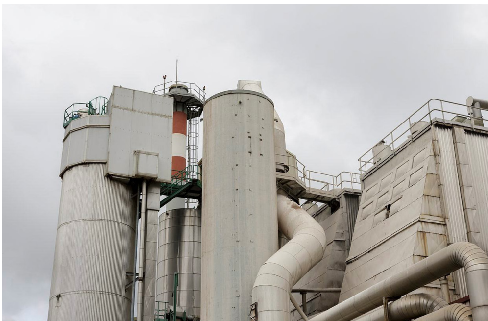
>> Incineradora de Campdorà.
