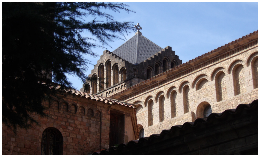
>> Vista exterior d'un dels encreuaments del transsepte amb la nau principal.
