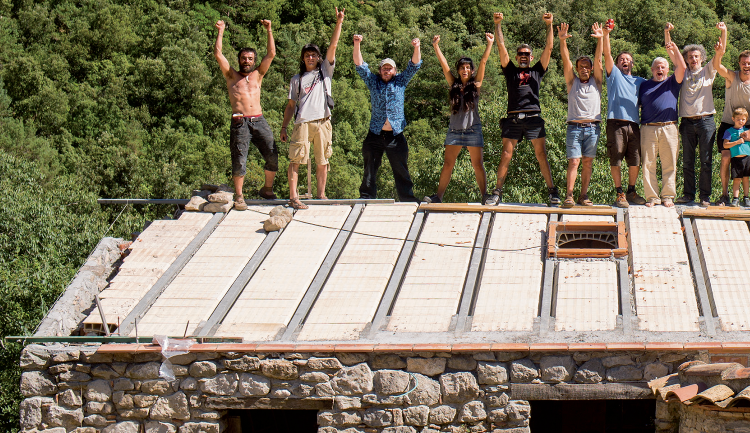
>> Celebrant la construcció de la coberta del mas La Vall. (Autoria: ESTEVE SERRA)
