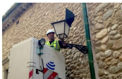
>> Operari fent tasques de manteniment de l'enllumenat. (Font: CILMA)
