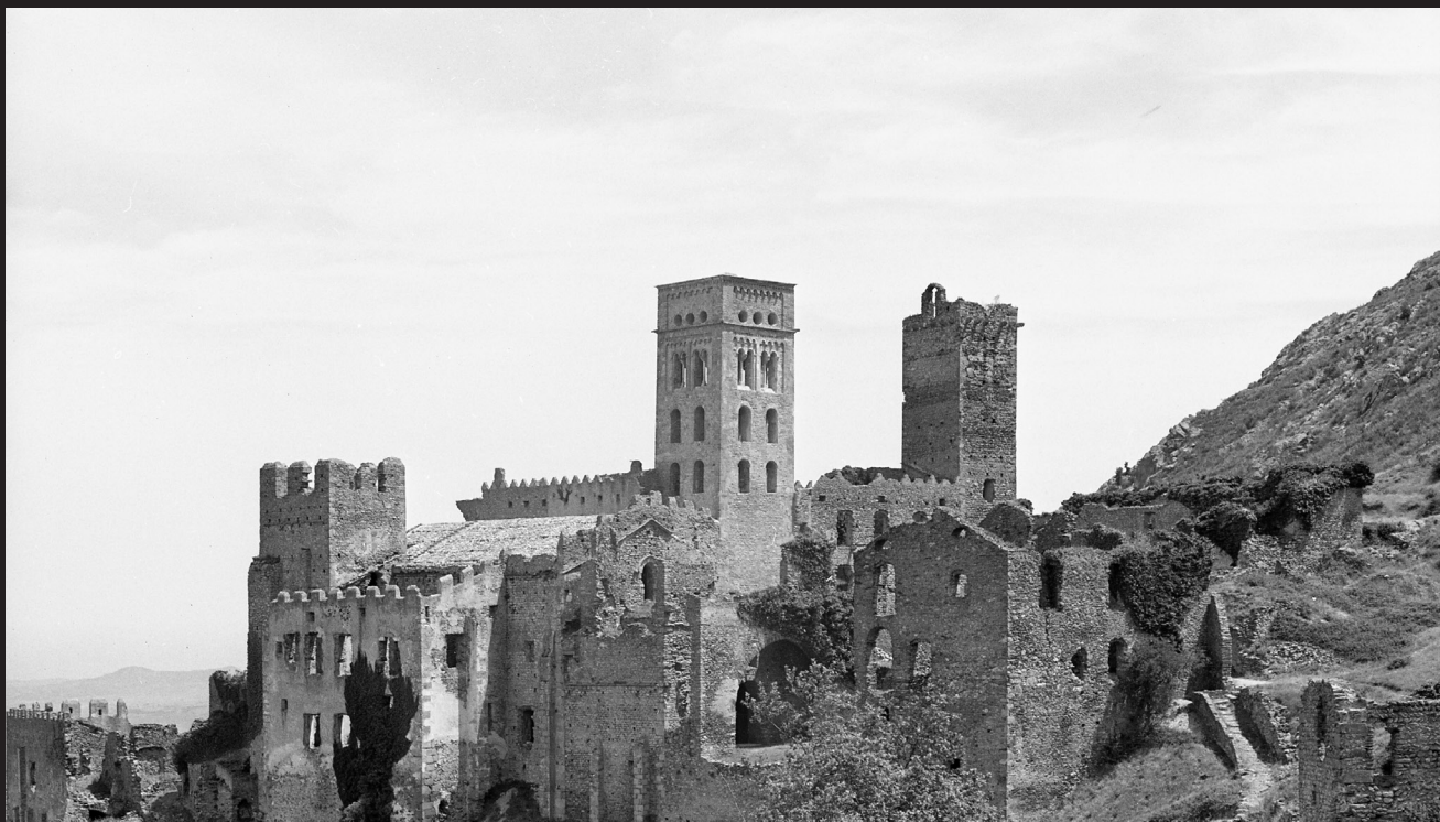
Monestir de Sant Pere de Rodes, degradat, amb dependències sense teulada i obertures sense finestres.
