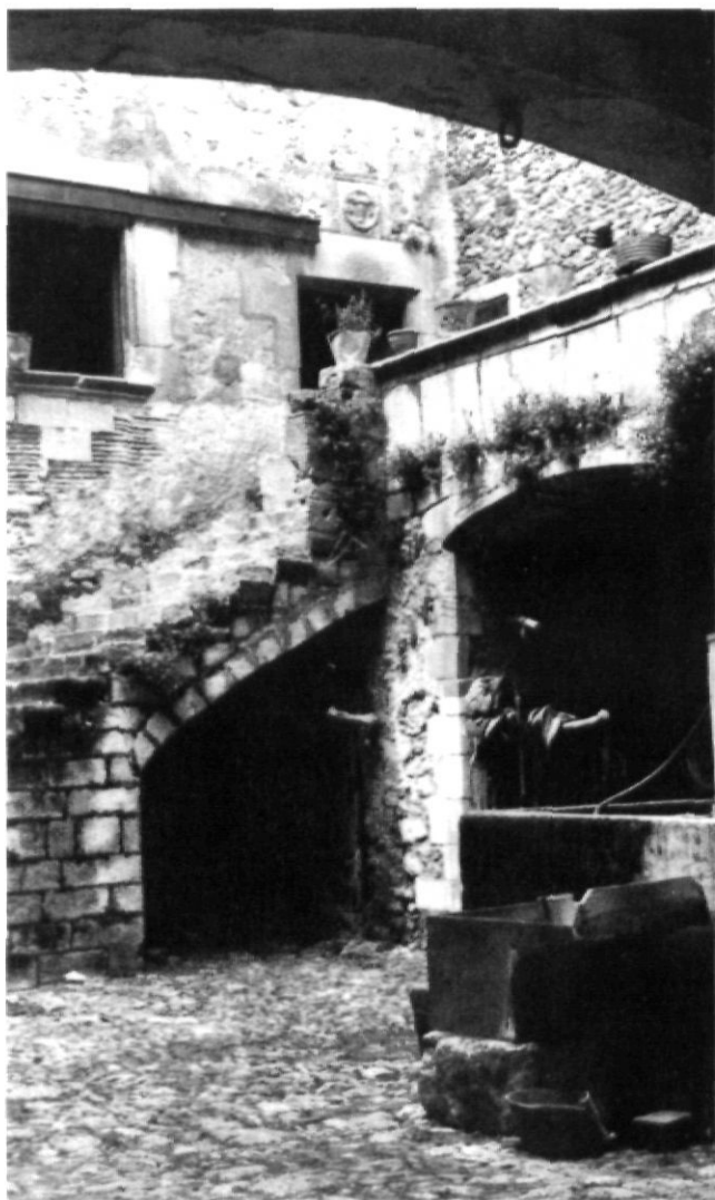
Racó del pati de la casa forta dels Margarit, a Sant Gregori, abans de la seva recent restauració.
