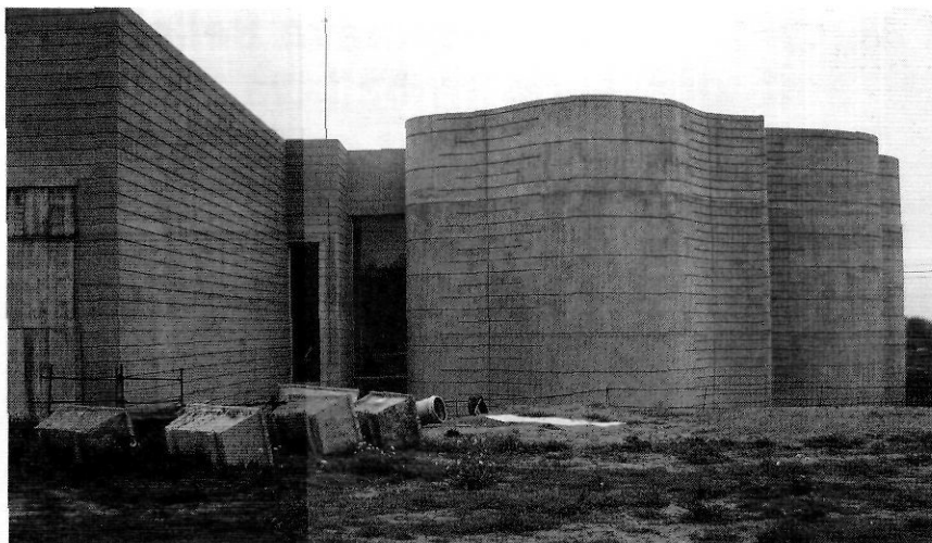
Exterior de l'edifici de Rafael Moneo.
