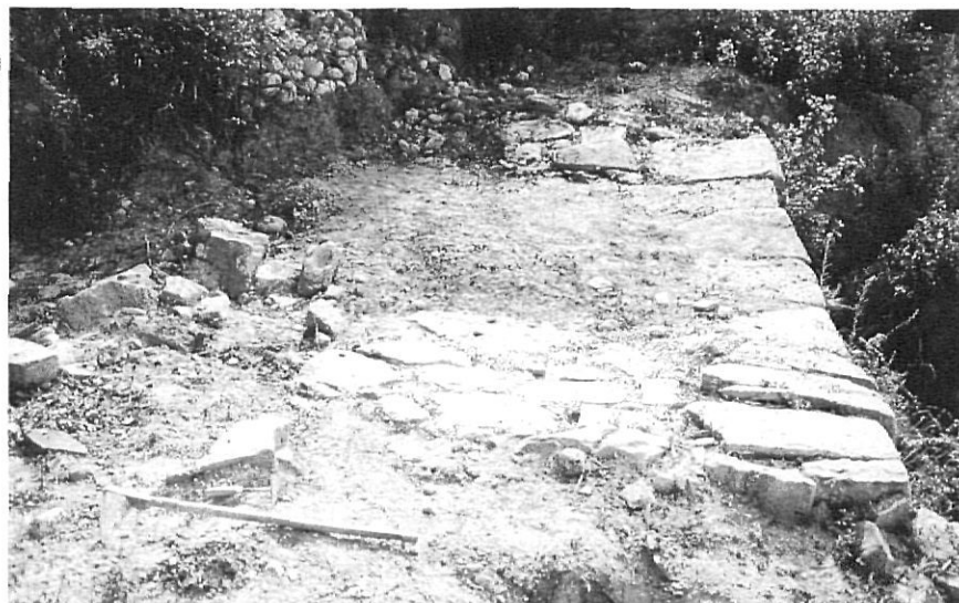
El pont Trencat. Detall dels carreus que sostenen el tram que creua el Fluvià i que s'atribueixen a l'època romana.
