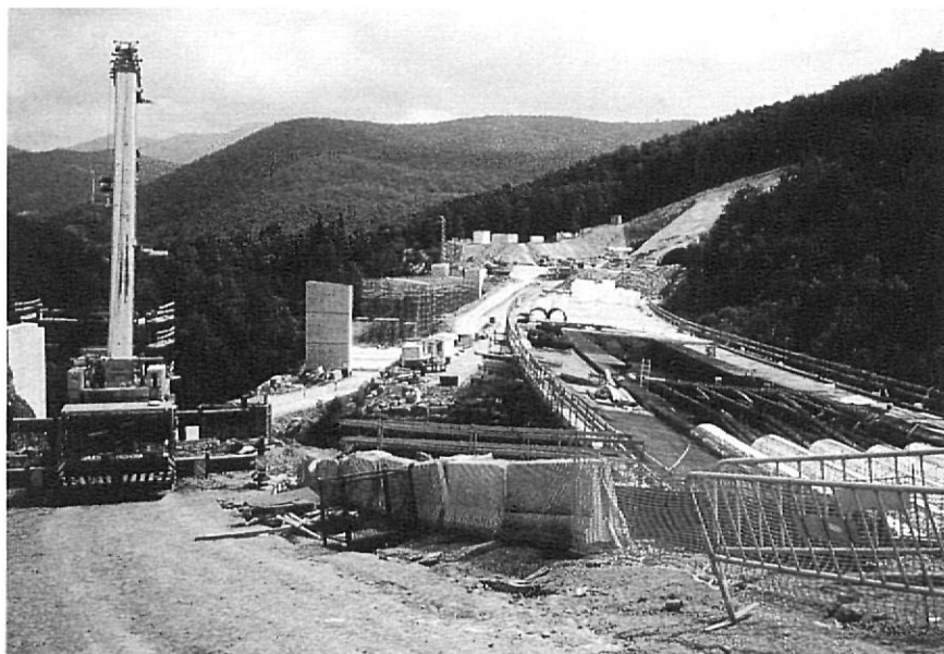
Aspecte de les obres de l'autovia, corresponents als ponts de les boques de ponent, al pla de Begudà.
