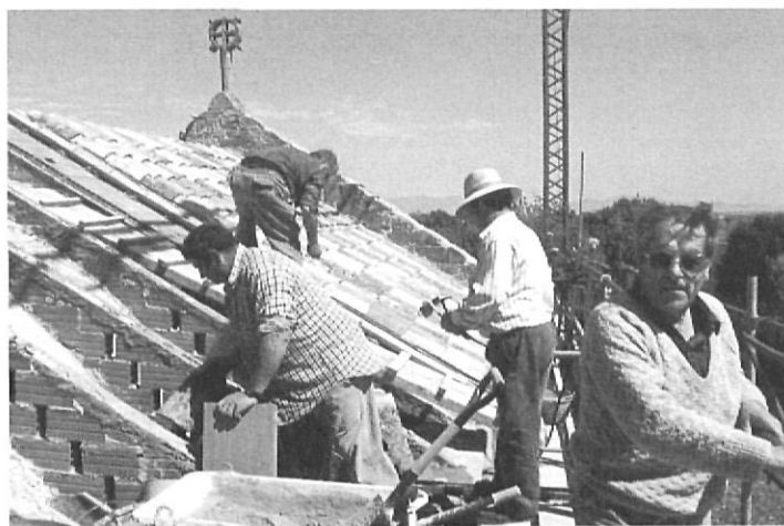
La brigada de restauració en plena tasca.
