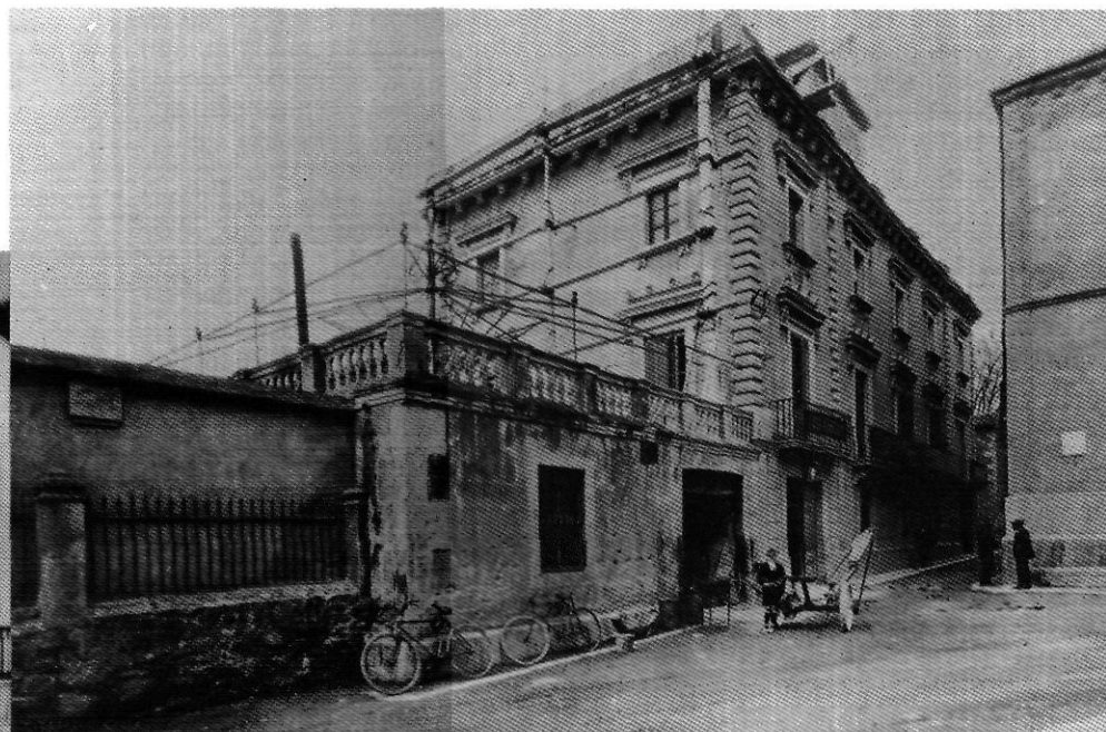
Edifici de "la Caixa", Torroella de Montgrí, enderrocat el 1977.
