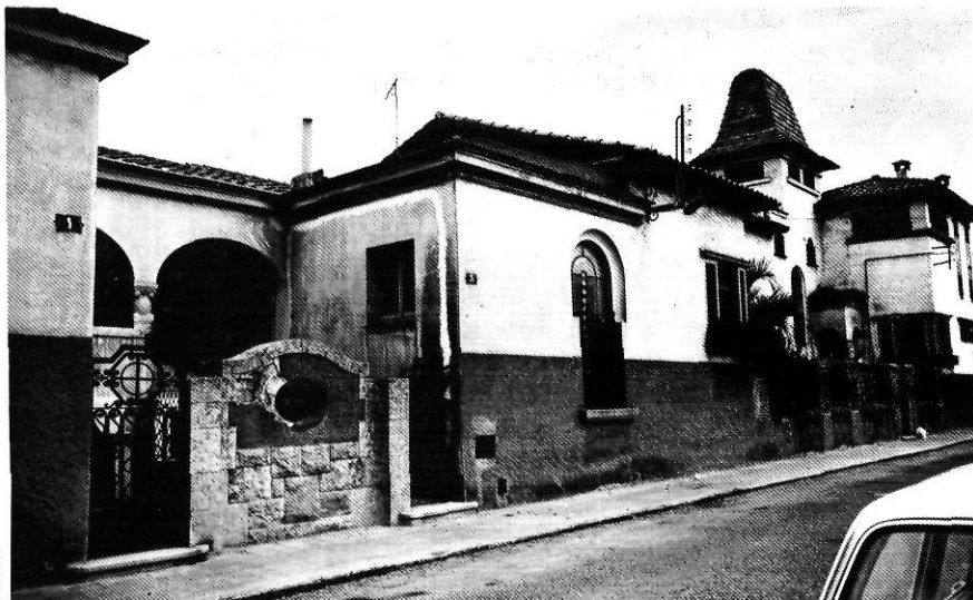
Urbanització Teixidor, carretera de Sta. Eugènia i carrer Ibèria, de Girona. Enderrocada el 1974.
