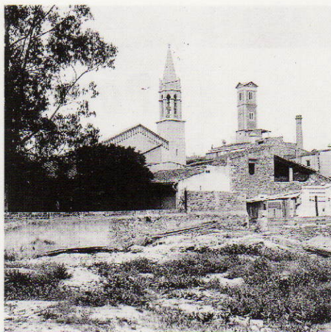
El servei d'aigua corrent existia a la ciutat des del 1869. L'any 1898 es construí la "Torre de les aigües" al Mercadal.
