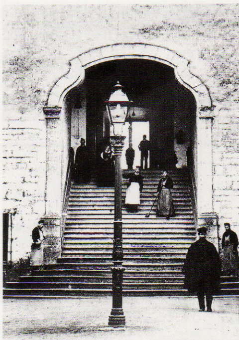
Girona fou pionera en la instal·lació de l'enllumenat públic elèctric.
