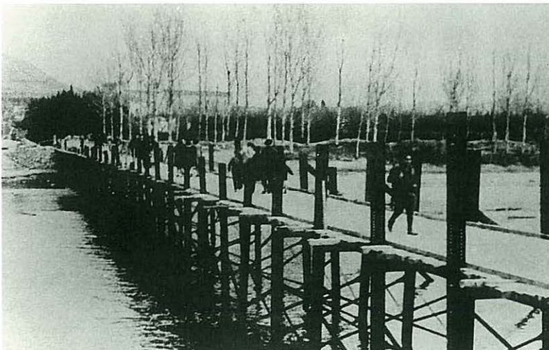
Pasarel·la provisional que connectava Gualta amb Torroella.
