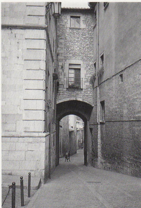
El portal de Sobreportes, sobre la Via Augusta.
