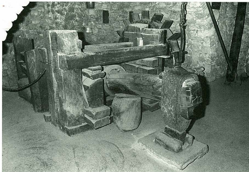
Martinet conservat a l'arxiu-museu de Ripoll. Era mogut per una roda introduïda en un canal del riu, mitjançant un senzill sistema de transmissió
