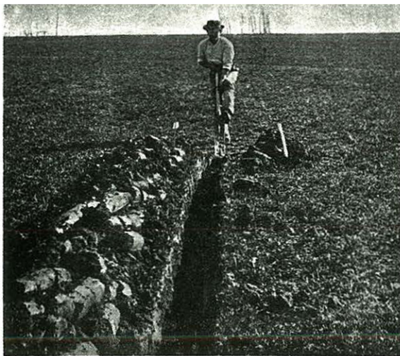
Treballs d'obertura d'un rec de drenatge.
