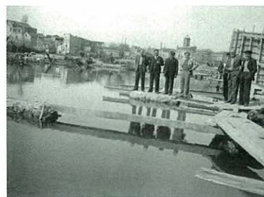
El farmacèutic, Joan Sabater, Francesc Serra Geli i Miquel Estany, entre altres, realitzen una visita a les obres de construcció del pont.
