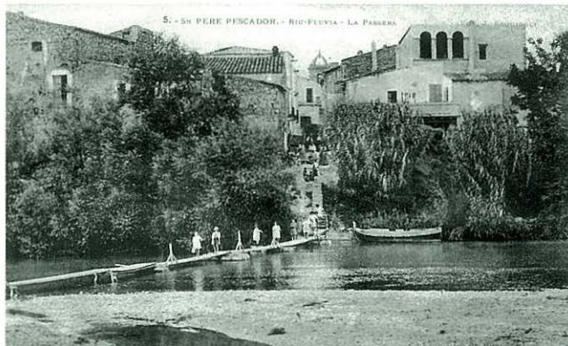
Les passerres, als anys vint, es trobaven instal·lades al tram del Fluvià que partia del carrer del Riu.
