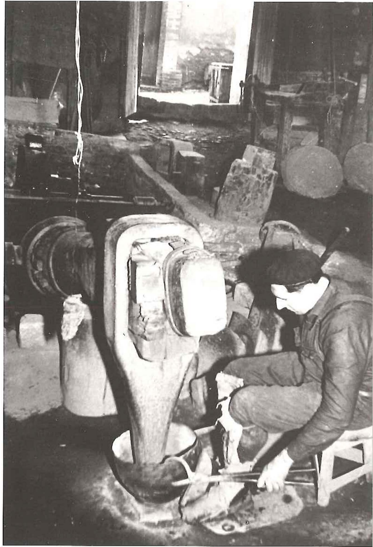
Martinet d'aram de la farga Palau, a Ripoll, darrer establiment en activitat.
