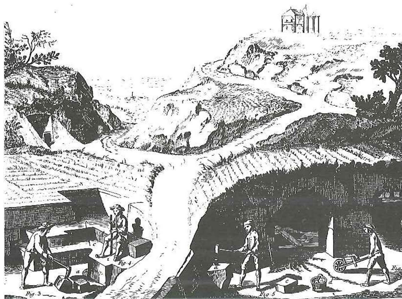
Els diferents sistemes d'extracció de mineral, al final del segle XVIII, segons un gravat de l'Encyclopédie.
