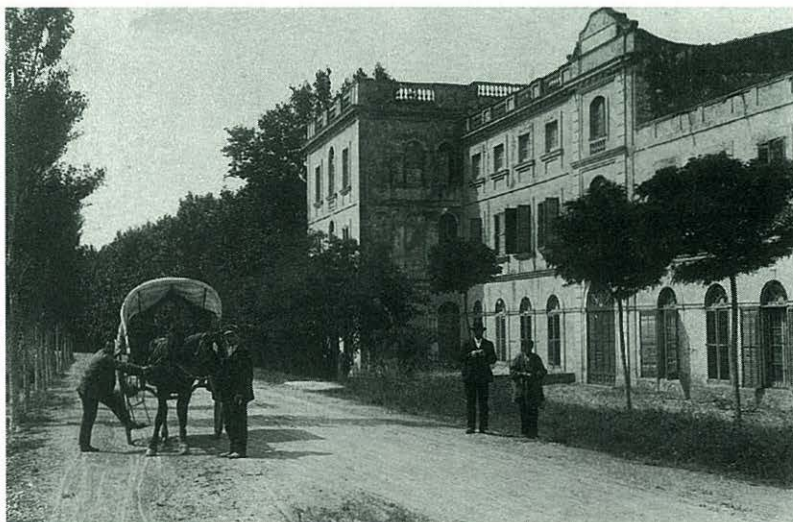
Façana del Balneari que donava a la carretera de França.
