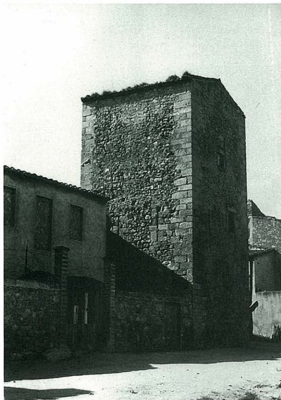
Torre de defensa del nucli fortificat de Capmany; pertany al recinte emmurallat que avui anomenem el Fort. Fou construït en l'època en què els Clusa foren barons del poble.
