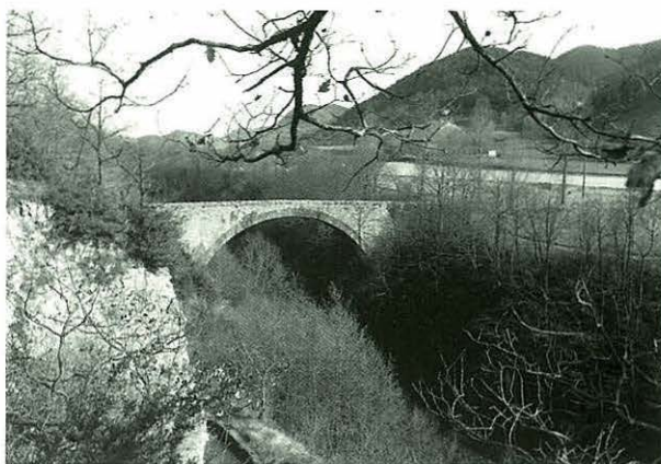
El pont de Perella, construït el 1915.
