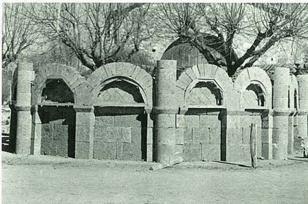
L'absis central, abans de reconstruir-lo en el seu lloc original, va ser muntat per tal de comprovar-ne les proporcions.
