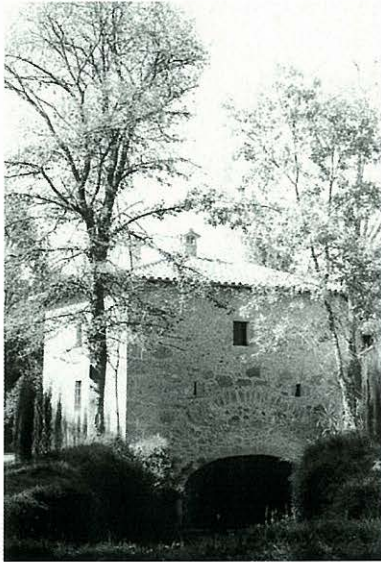
El molí d'en Prat té una forma pentagonal per a esquivar les freqüents rierades.
