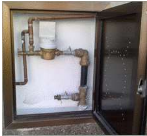
Exemples d'instal·lacions de comptador amb mòdul de telectectura incorporat
