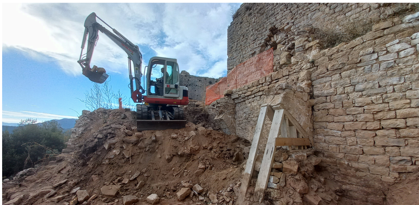
Fig. 4. Procés d'excavació del sector sud-est del castell
