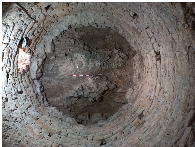
Fig. 3. Vista de la cambra inferior de la torre un cop excavada
