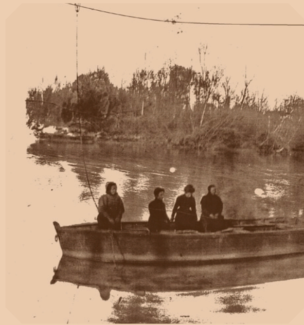
Imatge de 1919, en què s'aprecia el cable tensat, que anava d'un costat a l'altre de riu, i la cadena que lligava la barca
