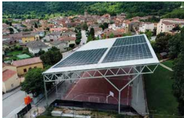
Plaques solars a la coberta de la pista poliesportiva Quima Casas
