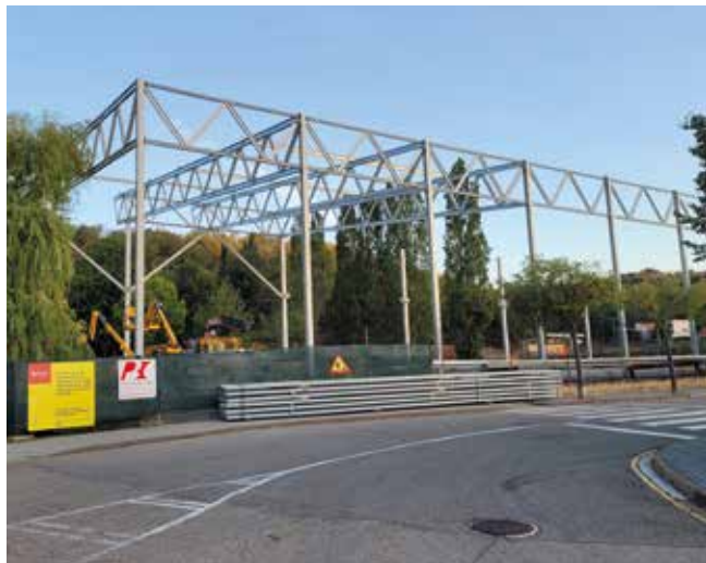
Inici de les obres de la pista poliesportiva. Agost 2023
