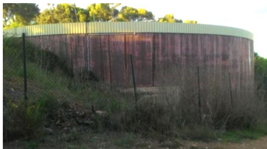
Figura 4 - Exterior del dipòsit de Quermany.
