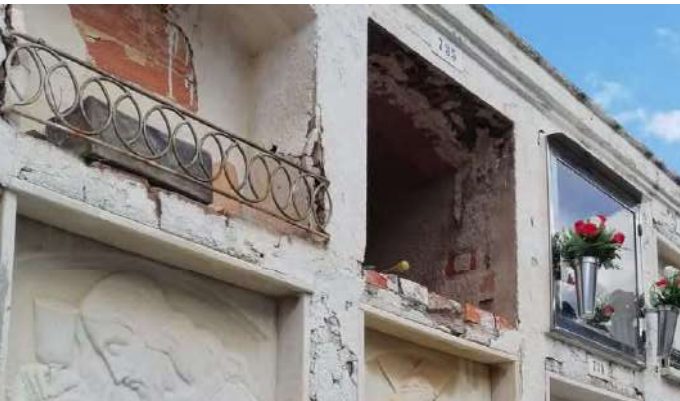
IMATGES DE LES PATOLOGIES GREUS EN ELS REVESTIMENTS AMB RISC DE DESPRENIMENT
