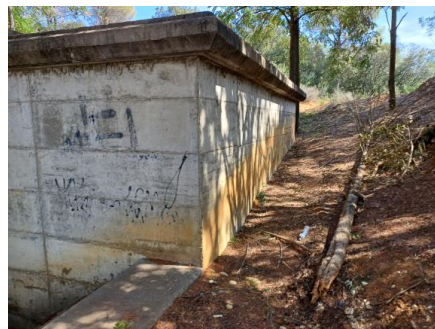
Fotografia 30. Exterior del dipòsit
