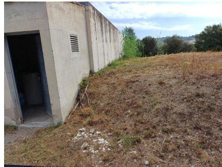
Fotografia 42. Exterior del dipòsit
