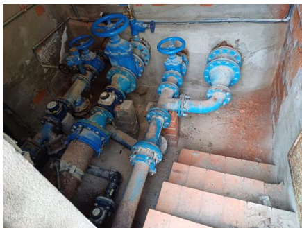
Fotografia 27. Conduccions entrada i sortida del dipòsit
