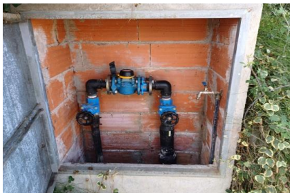
Fotografia 20. Conducció i comptador
