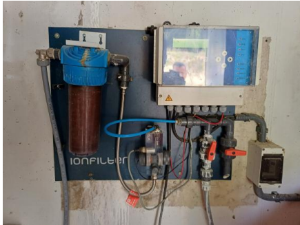
Fotografia 47. Analitzador de clor
