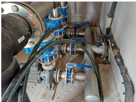
Fotografia 51. Conduccions sortida i grup de pressió
