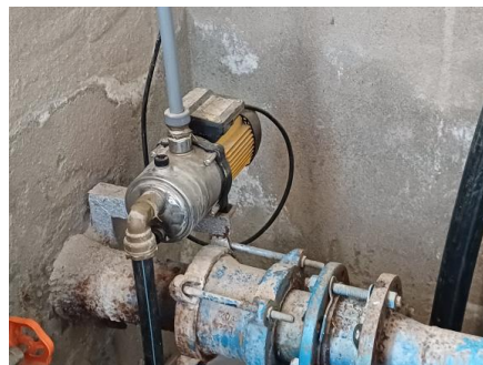
Fotografia 28. Bomba recirculadora
