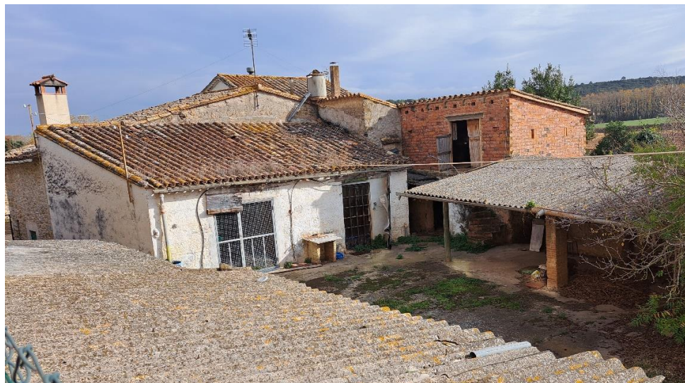
Façana posterior de Can Fèlix previ a l'enderroc dels coberts auxiliars
