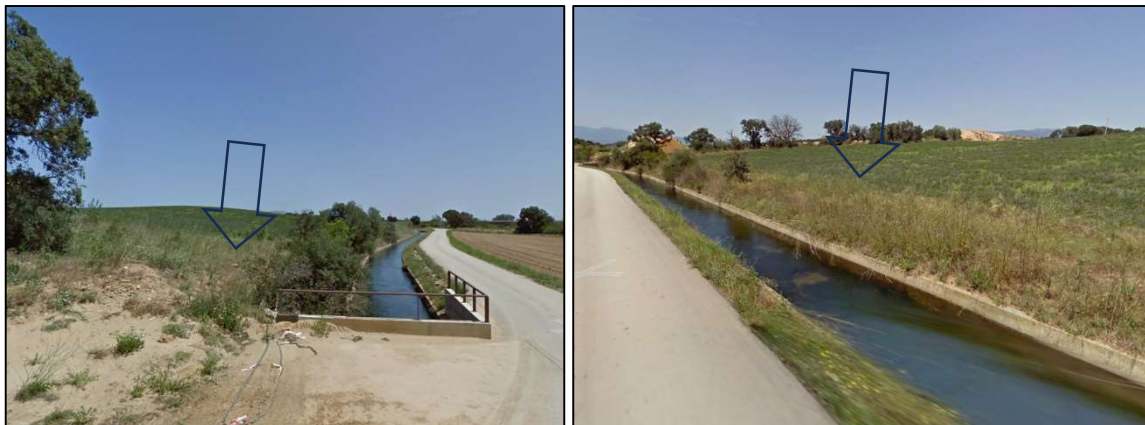
Imatge de la finca que es destinarà a la nova zona de Serveis Tècnics (ST) en sòl no urbanitzable (SNU) per a permetre la instal·lació d'una planta de valorització de residus d'enderroc i de la construcció.
