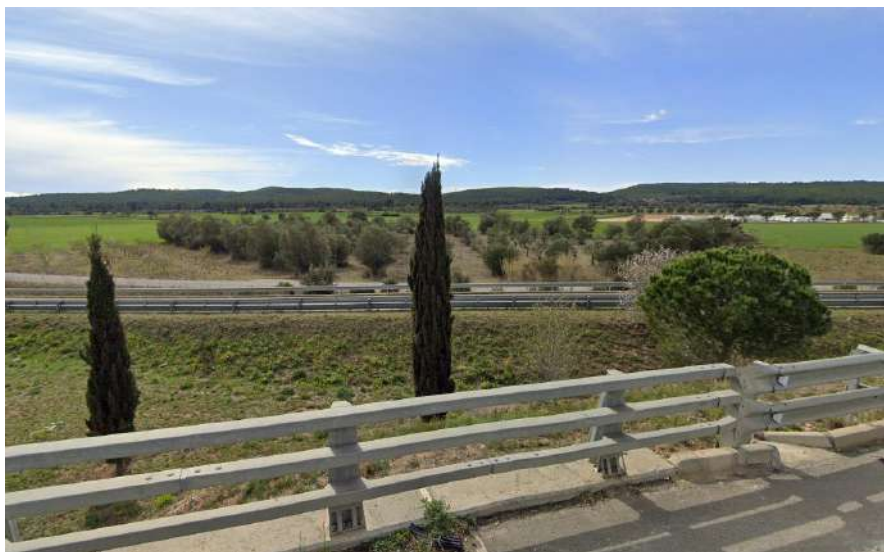
Imatge 1. Panoràmica del sector oriental dels terraprimis vista des del nus de la C-31 amb la GI-623 (TM Ventalló). Font: Google Street View.
