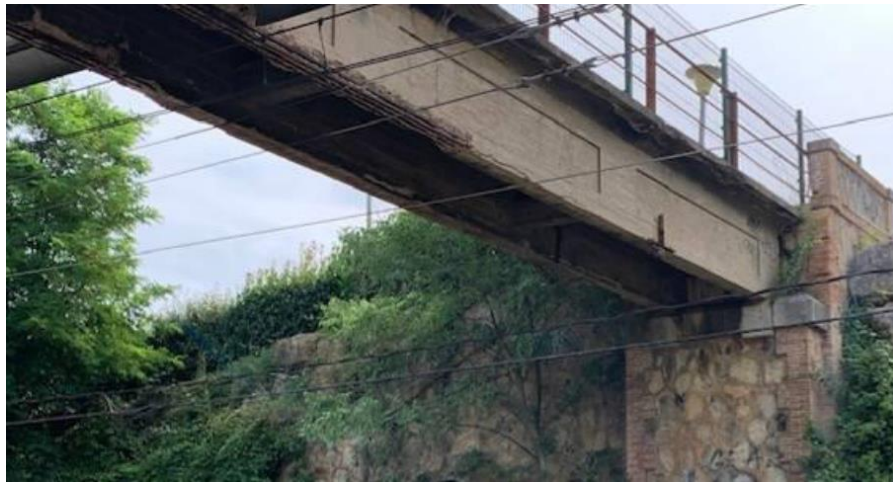
Figura 3. Imatge de l'estat actual del pont.
