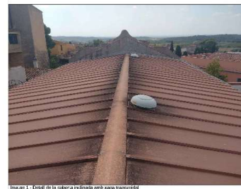
Imatge 1 - Detall de la coberta inclinada amb xapa trepuçada
