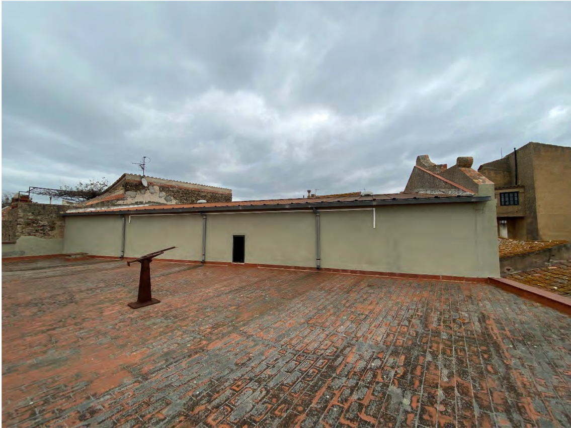
Vista general de la coberta transitable. Al fons, es pot veure la coberta de la sala
