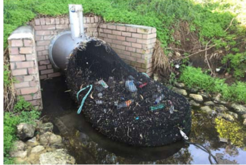
Imatge 34. Exemple de tamís de malla per a la retenció de residus sòlids en sobreexidors
