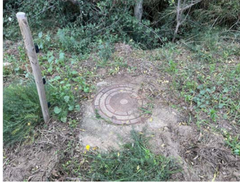
Imatge 24. Col·lector d'aigües residuals al marge esquerre de la riera
