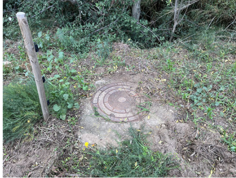
Imatge 2. Col·lector d'aigües residuals al marge esquerre de la riera
