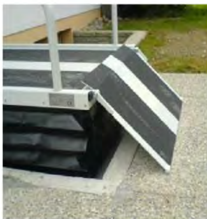
La rampa mecánica de acceso se pliega hacia abajo cuando la plataforma sube, creando una barrera de protección para las sillas de ruedas que están sobre la plataforma.
