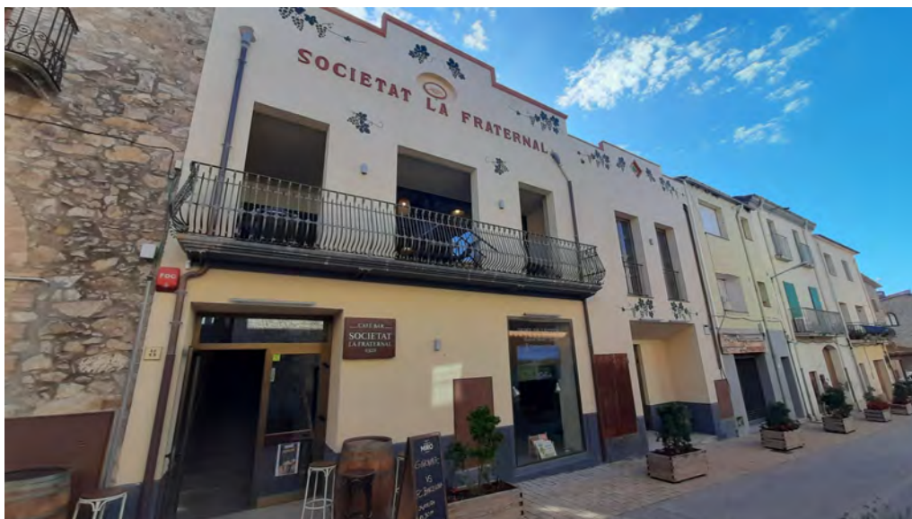
Façana principal de l'edifici, des del carrer Major. A l'esquerra la porta a substituir per una porta corredera automàtica.
