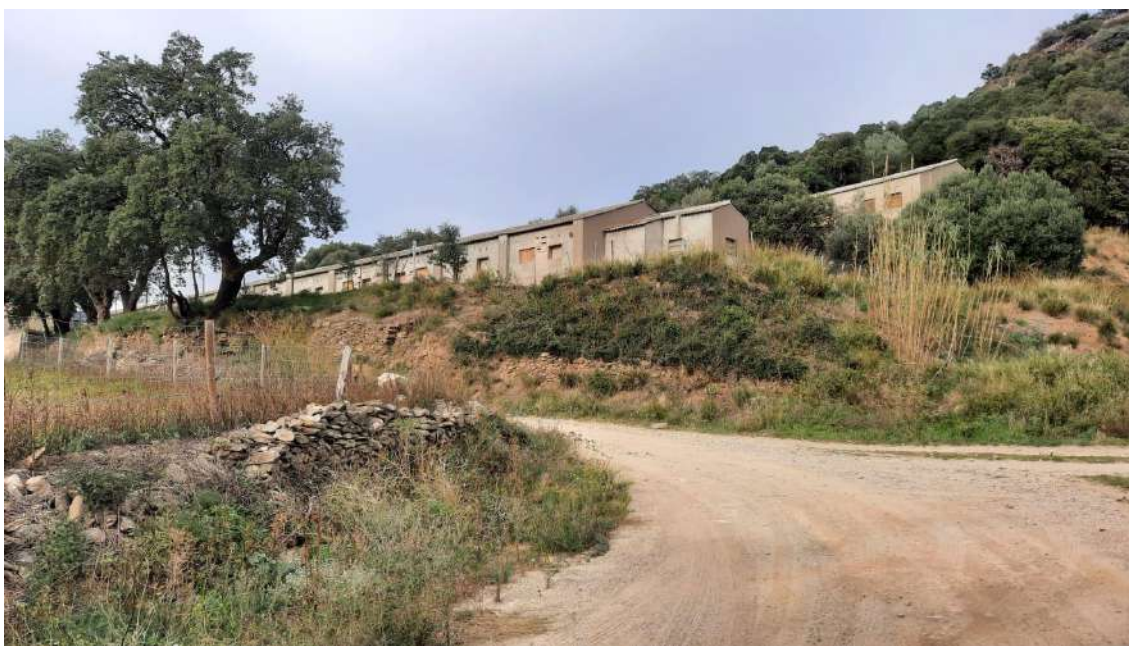
Fotografia 2: Vessant est de la finca. Desnivell dels terrenys on s'ubiquen les naus 6 i 7.
