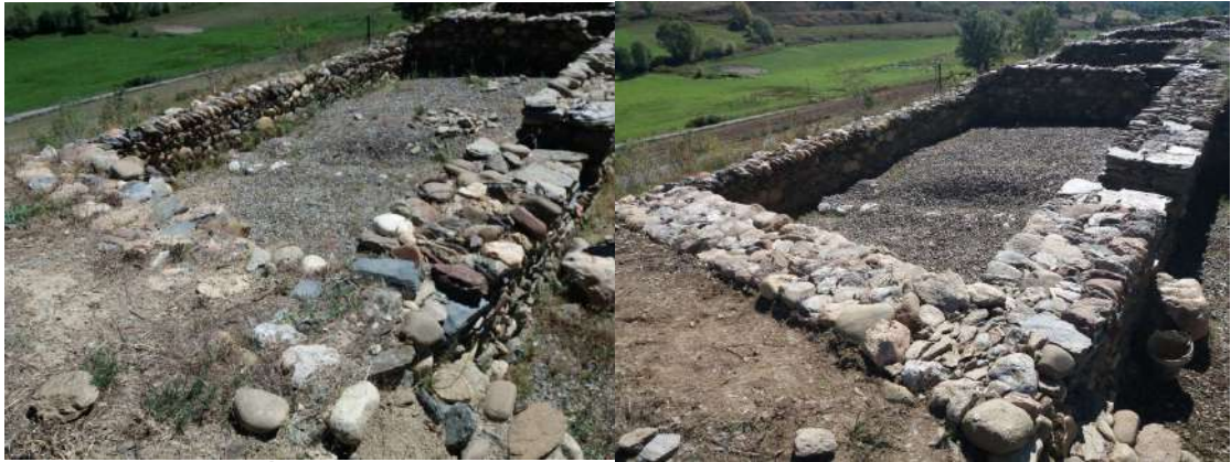
Fig. 31: Imatge de l'Àmbit Q abans i després de la consolidació
