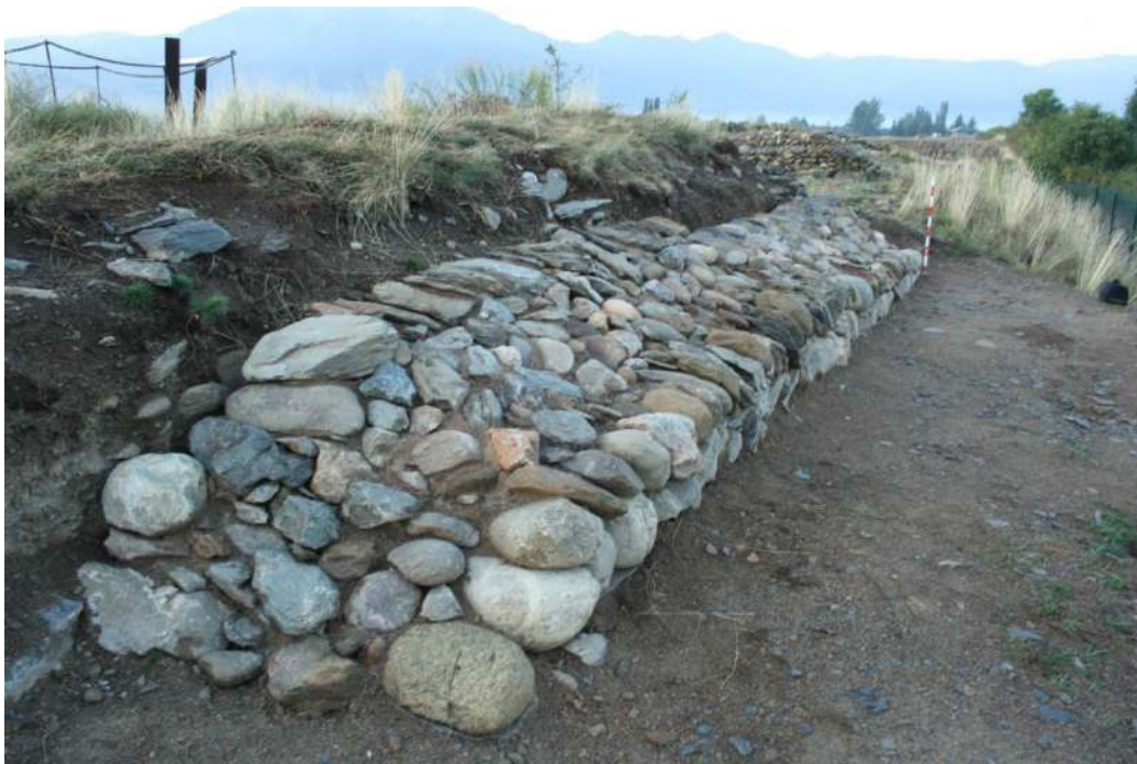
Fig. 32. Vista d'un tram de muralla medieval després de la consolidació
