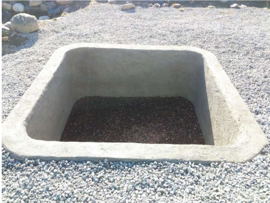
Fig 33. Detall del pou al final de la intervenció
