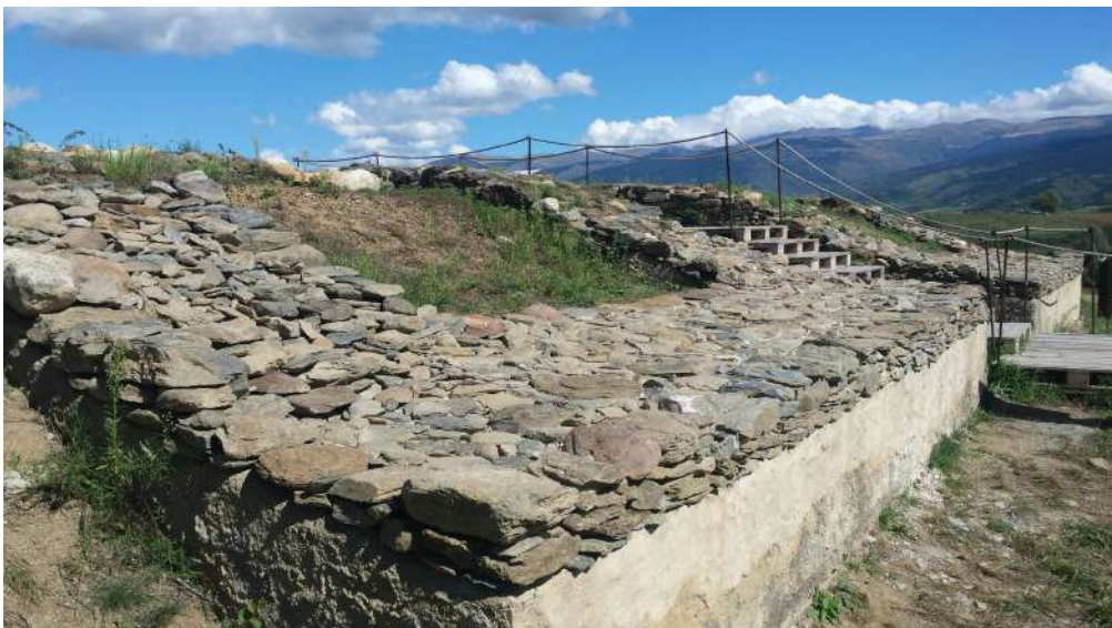
Fig. 29: Vista de les dues torres republicanes després de la restauració de 2015, on s'observa la coberta de pedres
