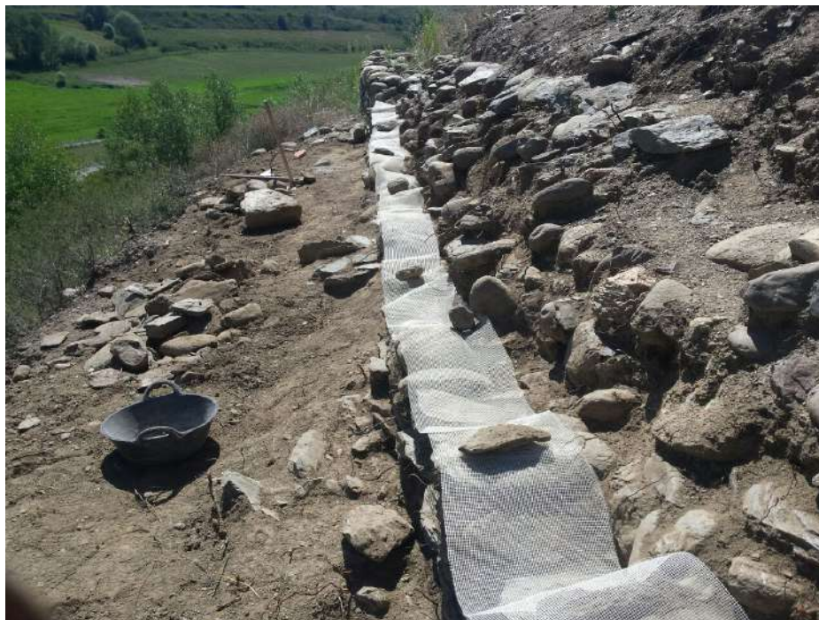
Fig. 57: Exemple de la col·locació de la xarxa de polietilè
