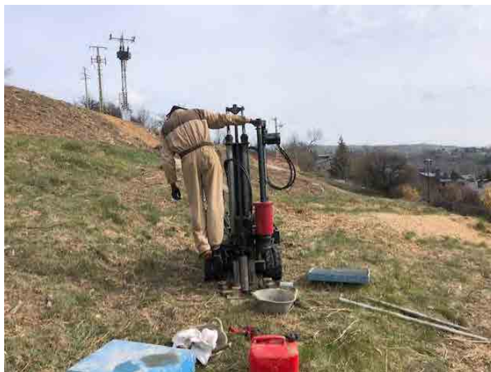
Situació i execució del sondeig 3.
