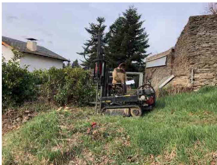
Situació i execució del penetròmetre 2.
