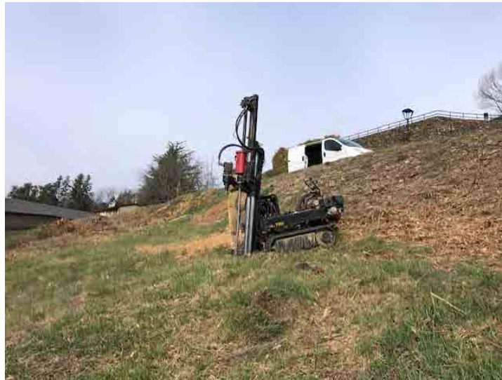
Situació i execució del penetròmetre 3.
