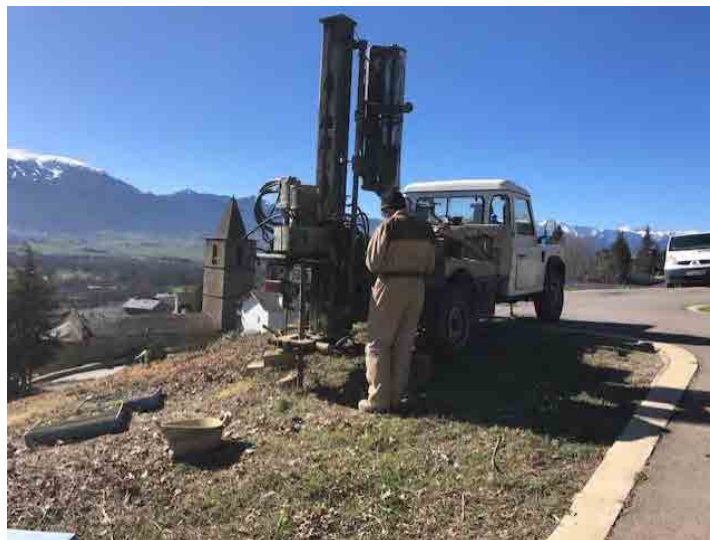
Situació i execució del sondeig 1.
