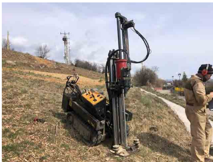
Situació i execució del penetròmetre 5.
