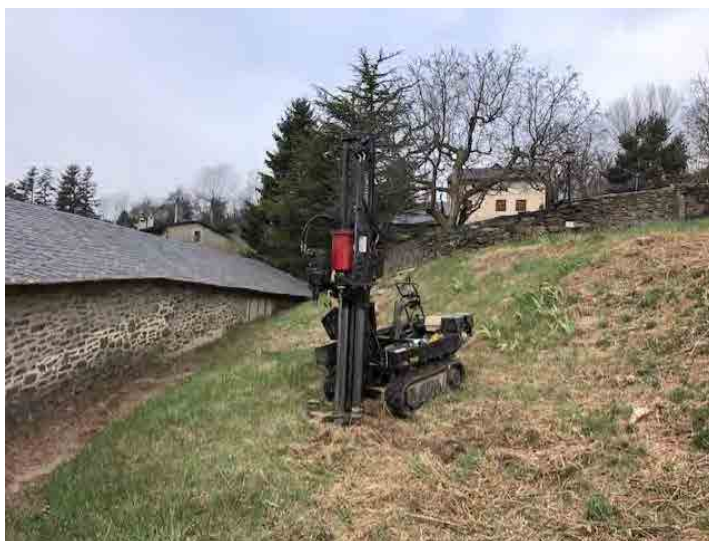
Situació i execució del penetròmetre 1.
