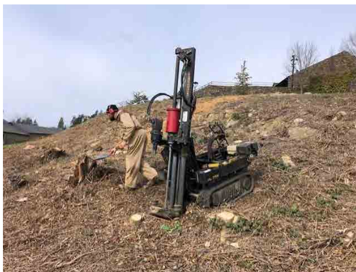
Situació i execució del penetròmetre 4.
